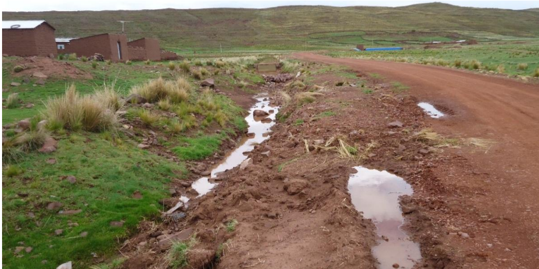
Imagen N° 05: Canal margen derecha rústico y en abandono
