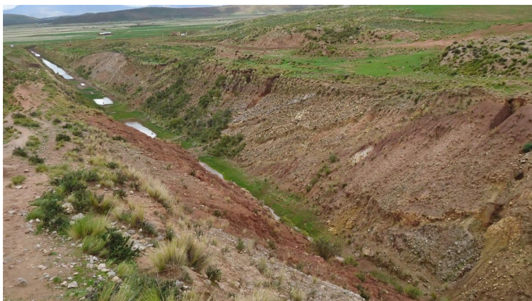
Imagen N° 04: Tramo de Canal Principal M. I. (salapata) Enterrado (11+300).
