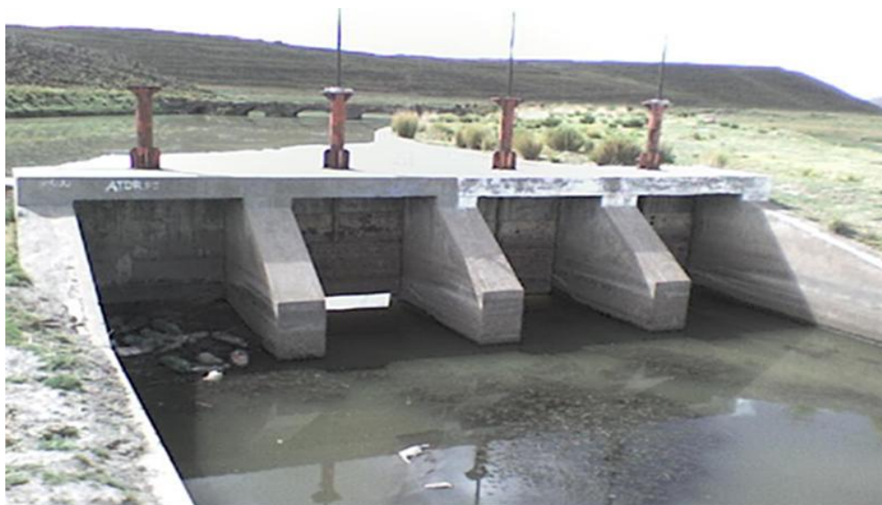
Imagen N° 03: Bocatoma ILLPA Compuerta de salida Margen Izquierda.
