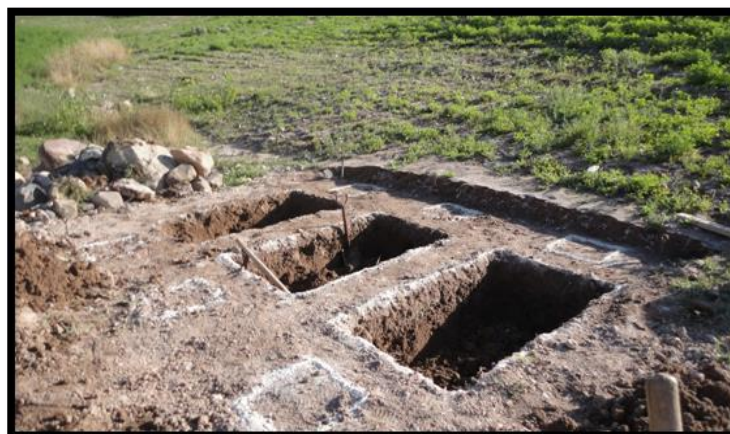
FIGURA 13. Fosas para los biodigestores
