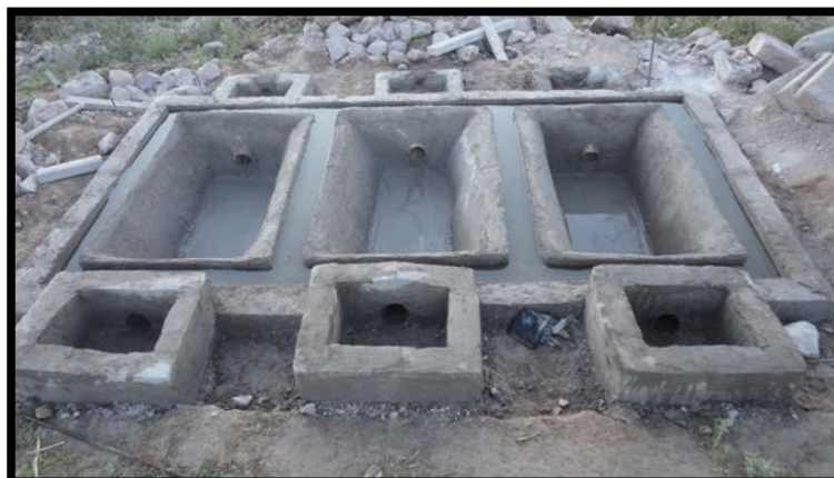
FIGURA 15. Prueba hidráulica de los biodigestores
