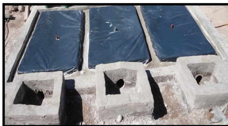
FIGURA 18. Instalación de la geomembrana en los biodigestores.
