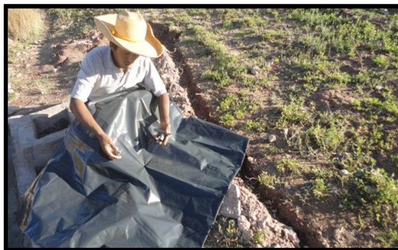
FIGURA 16. Extendido de la geomembrana
