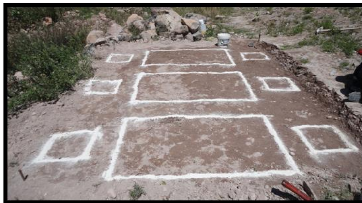
FIGURA 12. Trazo de los biodigestores.
