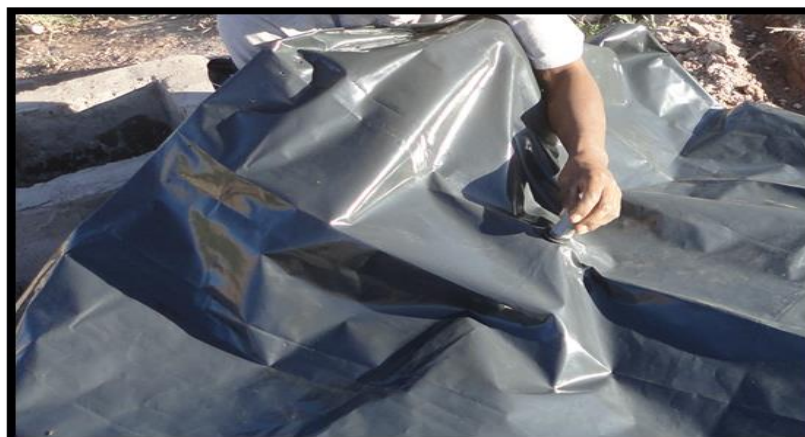
FIGURA 17. Instalacion de acoples a la tuberia de salida del biogas
