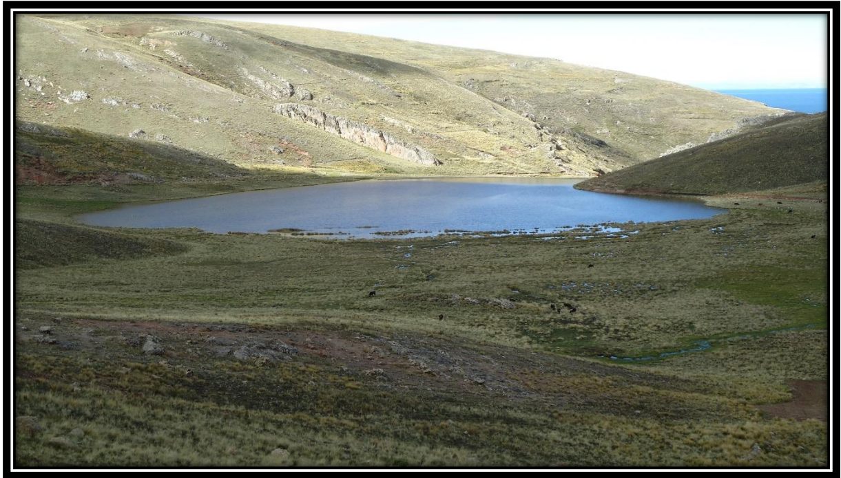
FOTO 01.- SISTEMA DE RIEGO JARUNI CARMBICO : REPRESA HOROCCO
