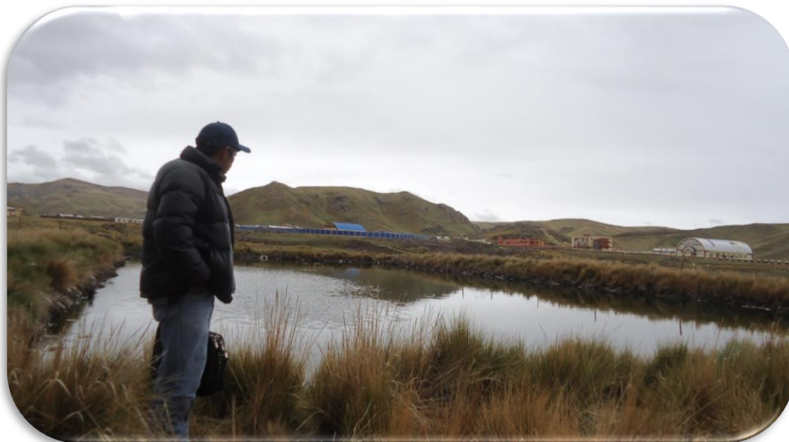
FOTO N° 01: Se observa las lagunas primarias de estabilización distribuidas en paralelo de la Planta de Tratamiento de Aguas Residuales PTAR del Distrito de Ajoyani - Carabaya – Puno
