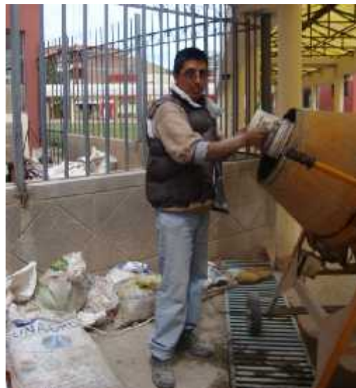
Grafico 15 Preparación del concreto
