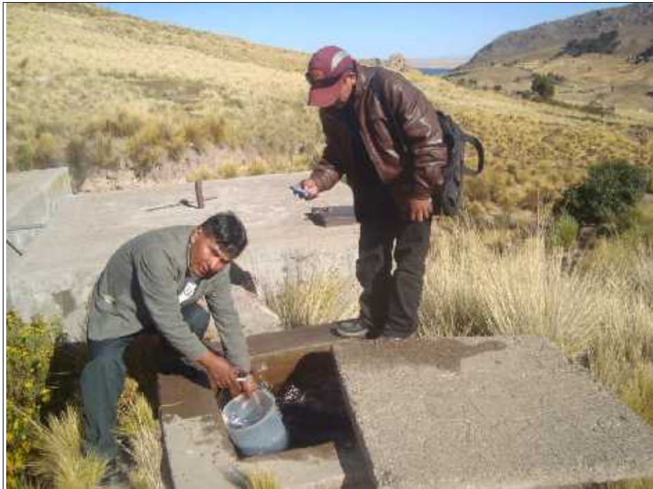
Fotografía N° 05 Trabajos de Aforo en Ojos de Agua N° 03 - MANANTIALES
