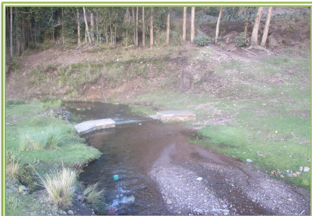
Fotografía N° 3. Vista de la sedimentación acumulada en diques sedimentadores, ubicados en las subcuencas de río Jayllihuaya ( 13-06-2014 )
