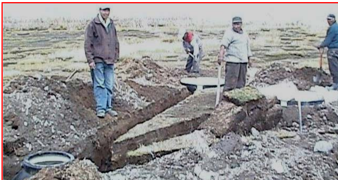
Foto 01. Excavación de hoyos e instalación de lisímetros y tanque colector.
