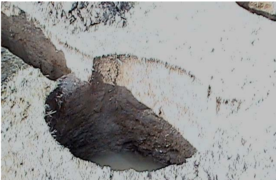
Foto 04: Vista zanja excavada para el Lisímetro.
