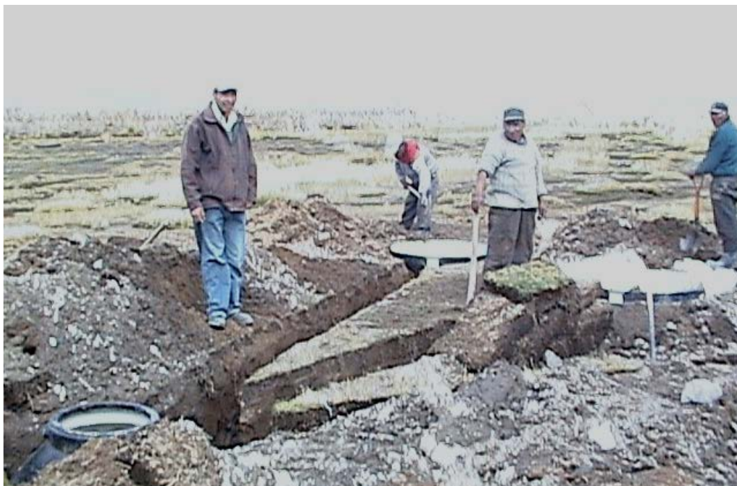
Foto 02: Vista en el proceso de instalación de Lisímetros y tanque de lectura.
