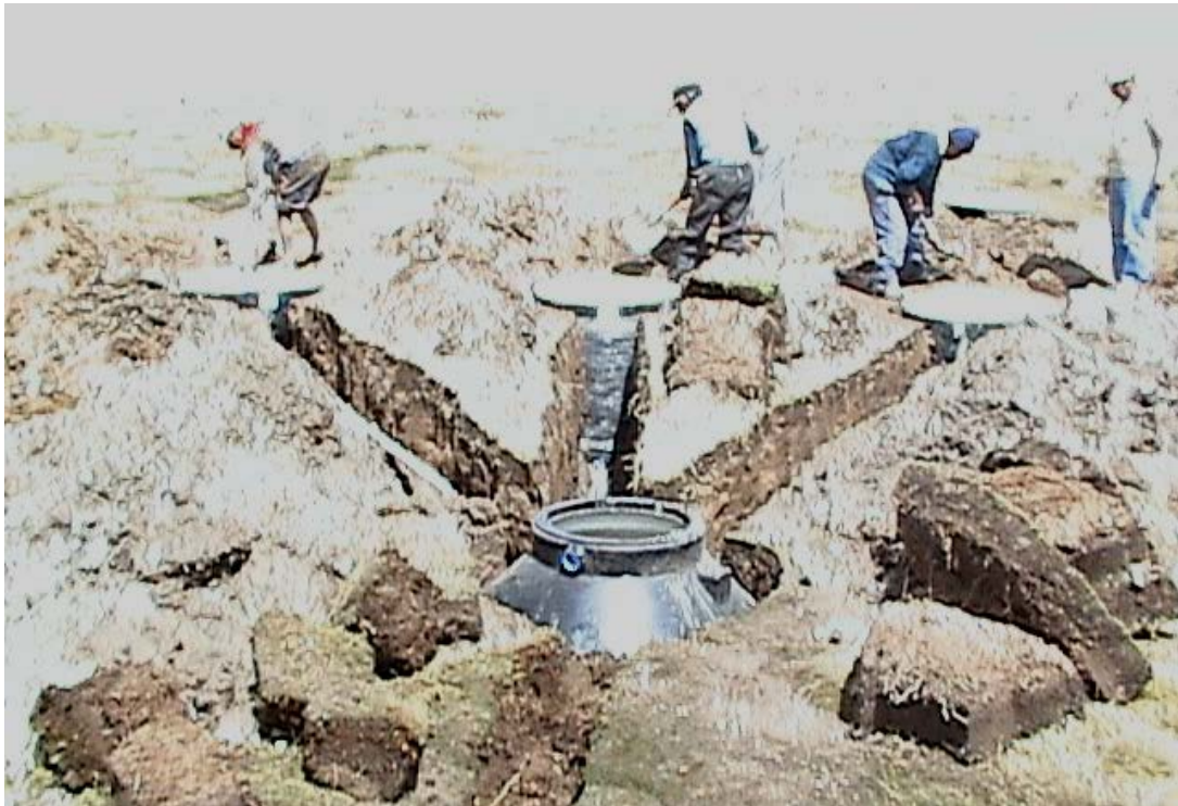
Foto 01: Excavación, instalación y nivelación de lisímetros y el tanque de lectura.
