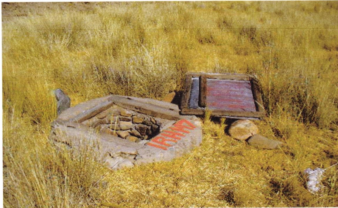
Foto N° 01.- Se Observa Un Pozo Tipo Rustico Que Es Utilizado Como Fuente De Agua Para Consumo Humano y de animales, pozo ubicado en sector de Pucca Mocco En Collana Cabanilla
