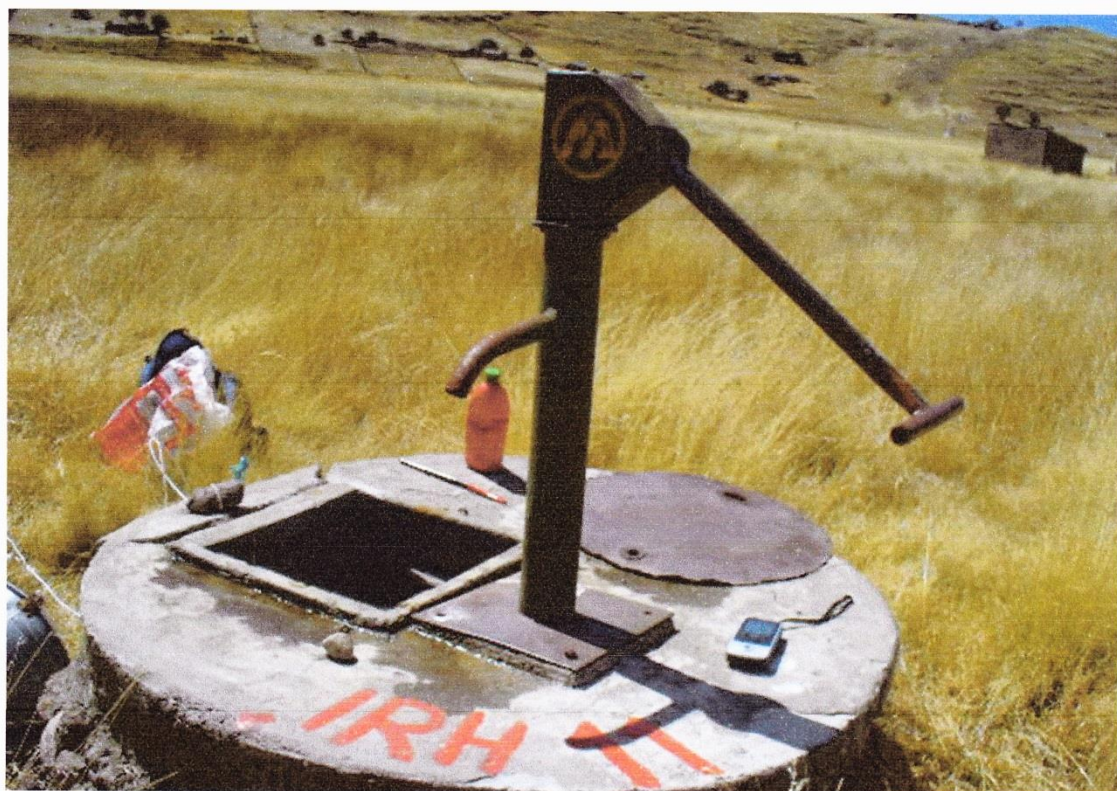
Foto N° 03.- Pozo equipado con bomba manual en buen estado de funcionamiento para la extracción de agua para consumo humano y de animales ubicado en sector Cantería
