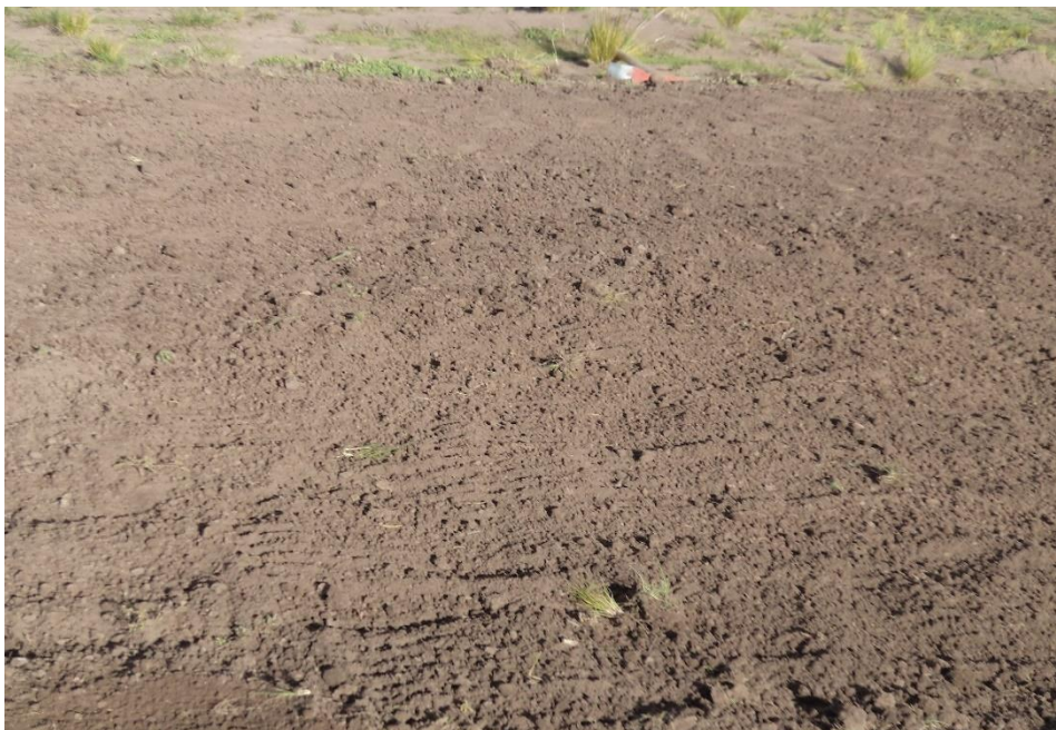
FOTO N° 04: PARTE DEL TERRENO YA NIVELADO USANDO RECURSO HUMANO
