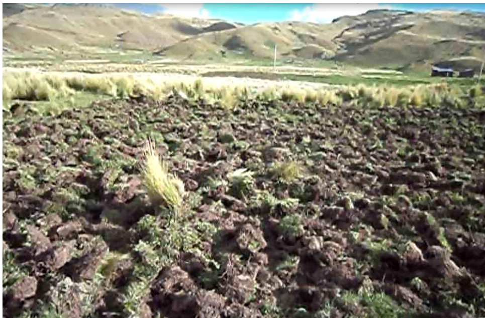
FOTO N° 02: TABAJO DE RUPTURA DE SUELO USANDO EL RECURSO MAQUINARIA
