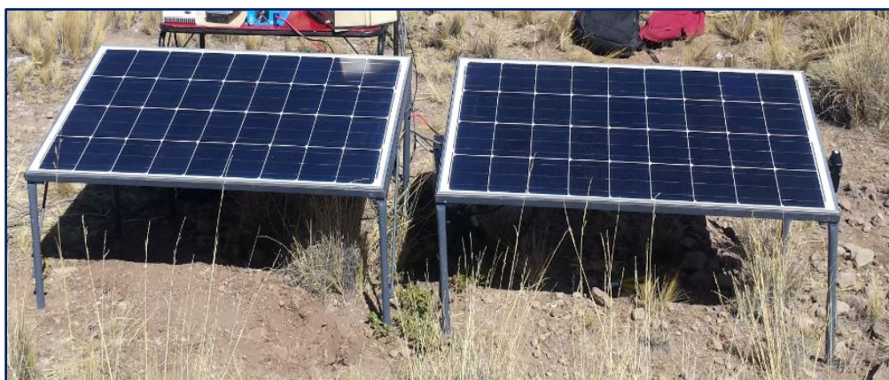
Figura 44: Montaje de Paneles Solares.
