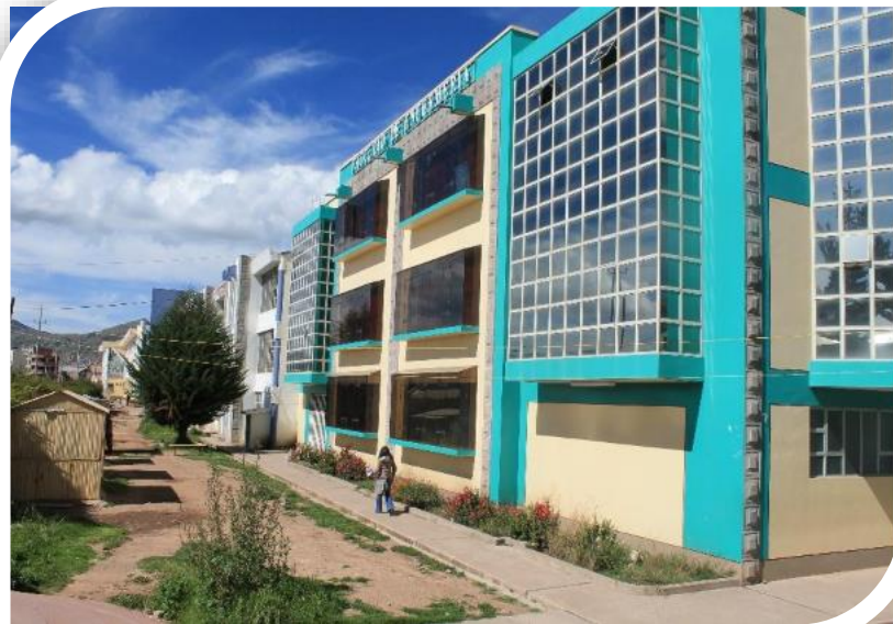
Instalaciones de la Facultad de Enfermería de la UNA
