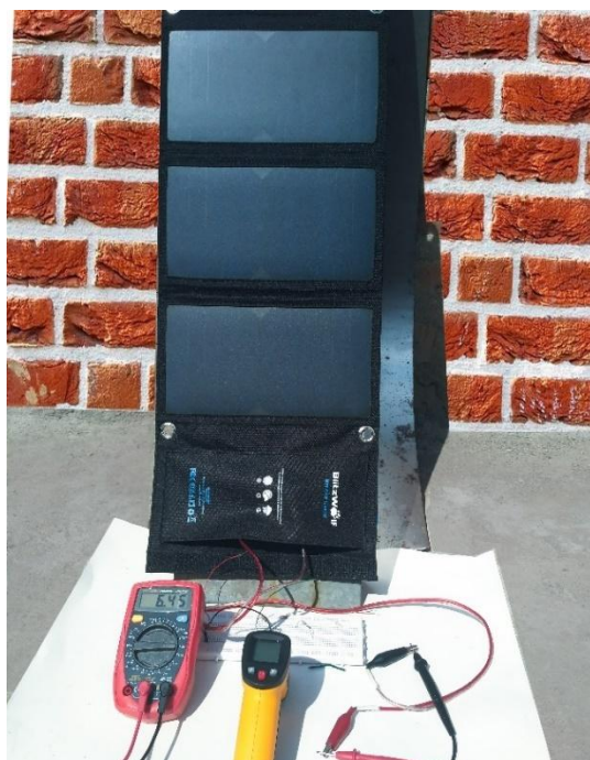
Figura 41: Medición de parámetros eléctricos para célula solar, en módulo PV modelo BW_L1 - 20W.
