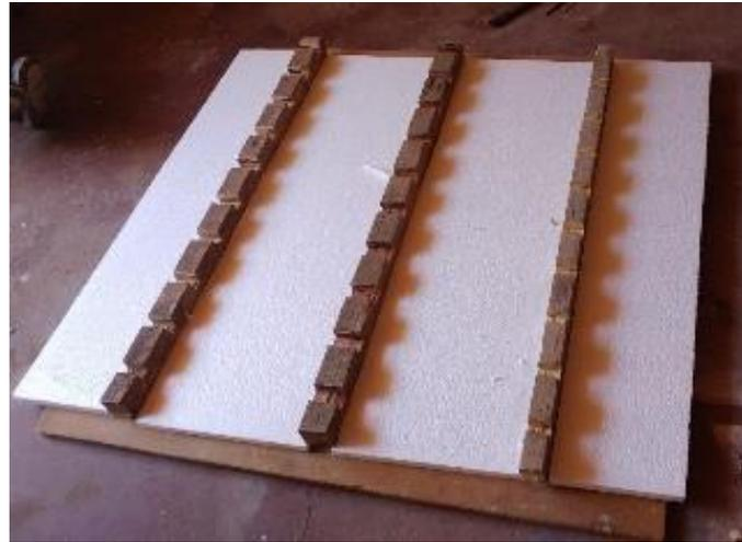
Figura N°A6: Instalación de Poliestireno expandido (tecnopor)
