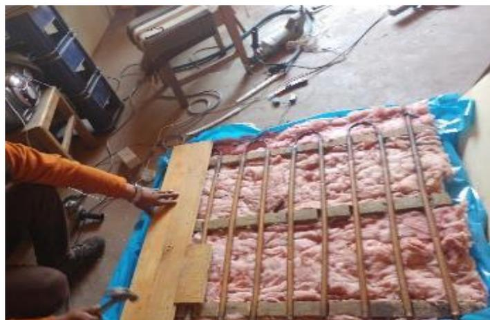
Figura N°A11: Instalación del piso (Machihembrado)
