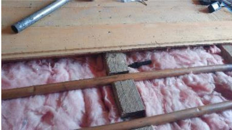
Figura N°A12: Posición de sensor de temperatura debajo del piso
