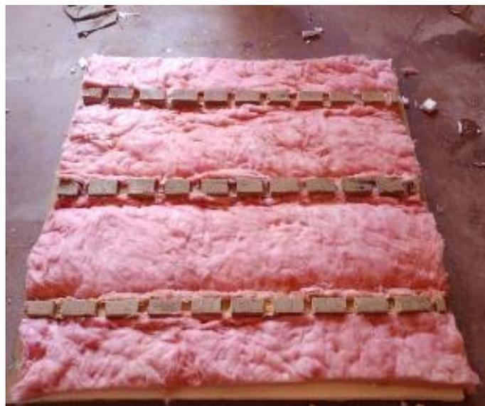
Figura N°A7: Instalación de lana de vidrio
