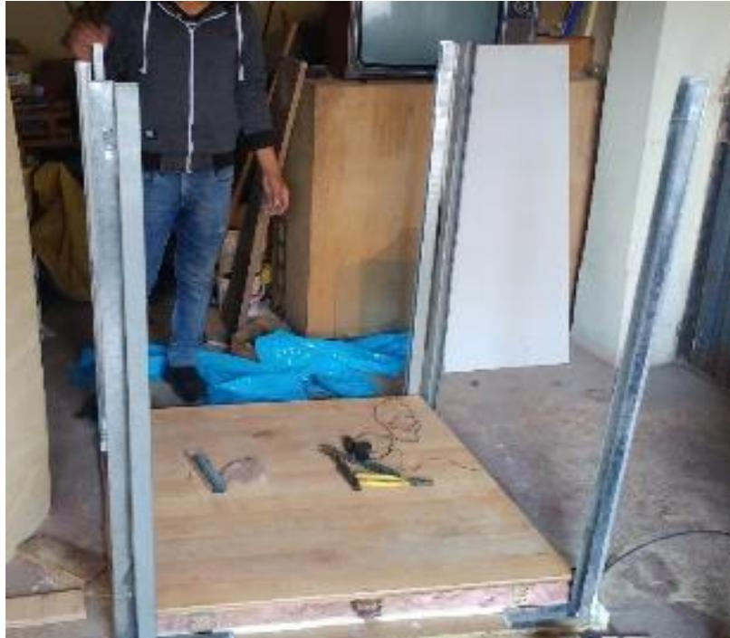
Figura N°A14: Parantes para la instalación de las paredes
