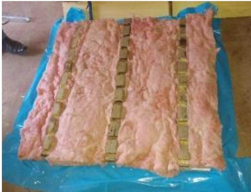
Figura N°A8: Instalación de todos los aislantes del piso
