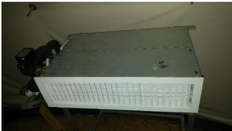
FIGURA E1: fancoil – sistema de calefacción con fancoils
