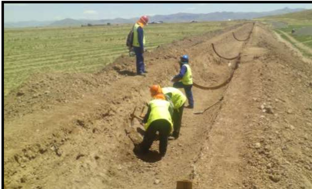
SE MUESTRA TRABAJOS DE LA PARTIDA REFINE DE CAJA CANAL A MANO
