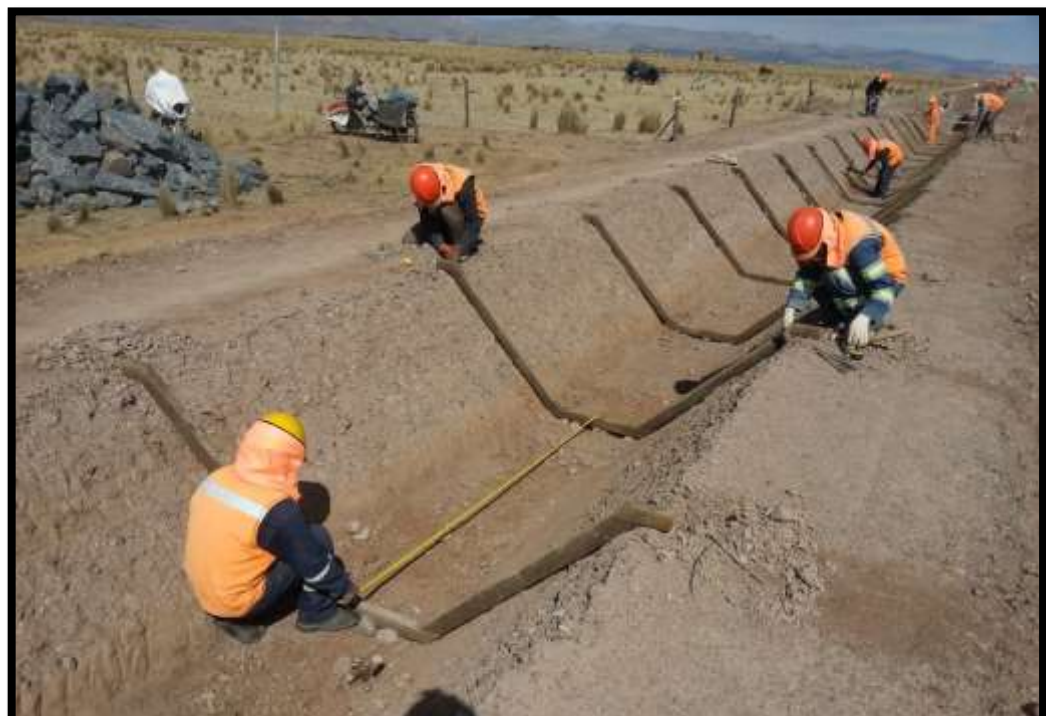
SE MUESTRA TRABAJOS DE LA PARTIDA COLOCACIÓN DE CERCHAS DE MADERA
