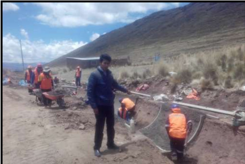
SE MUESTRA TRABAJOS DE LA PARTIDA CONCRETO F'c=175\text{kg/cm}^2 PARA REVESTIMIENTO DE CANALES
