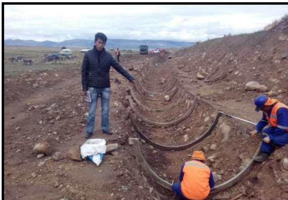
SE MUESTRA TRABAJOS DE LA PARTIDA COLOCACIÓN DE CERCHAS DE MADERA
