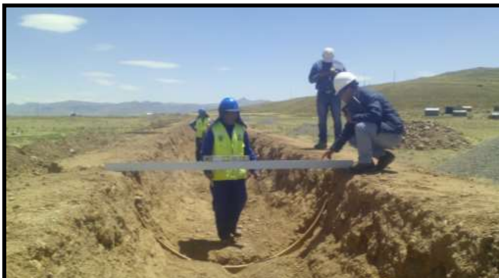
SE MUESTRA TRABAJOS DE COLOCACION DE CERCHA DE MADERA
