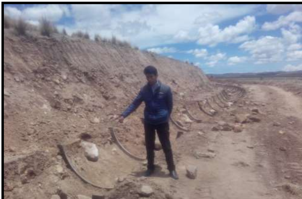
SE MUESTRA TRABAJOS DE LA PARTIDA COLOCACIÓN DE CERCHA DE MADERA
