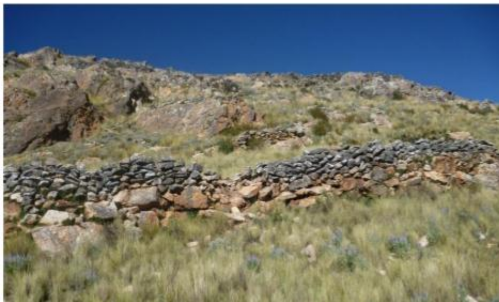
Imagen 29: vista frontal de las murallas de Iquinitu.
