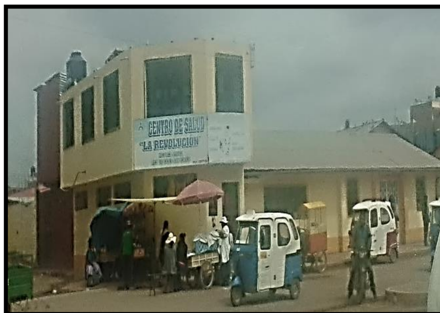
FIGURA 2: Infraestructura del establecimiento de Salud la Revolución
