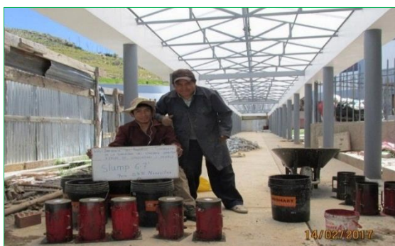
Figura 3.22: Moldes vaciados de un grupo de concreto.
