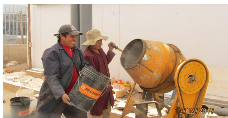
Figura 3.19: Mezclado del concreto
