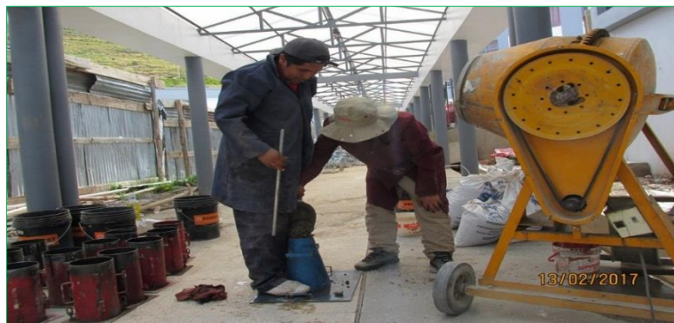
Figura 3.20: Comprobación del asentamiento.
