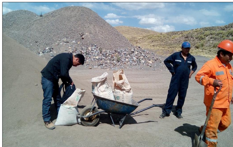
Figura N° 3. 2. Acopio de la Cantera Cabanillas
