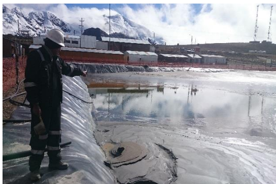
Foto N°1: Cancha de los relaves
