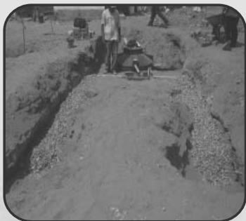
Tipo de zanjas de infiltración horizontal
