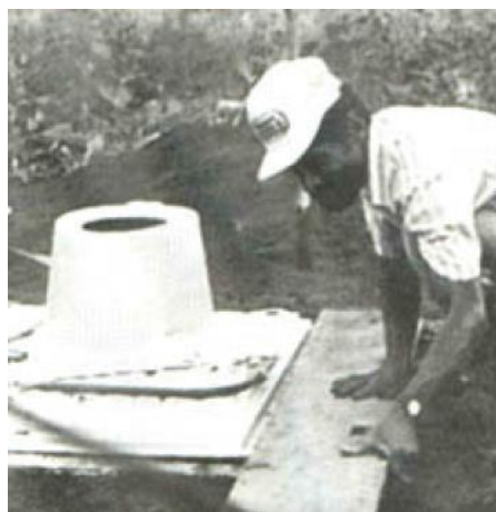
Figura 5.6. Letrina con asiento y piso de fibra de vidrio Fuente: (Organización Panamericana de la Salud, 1997)
