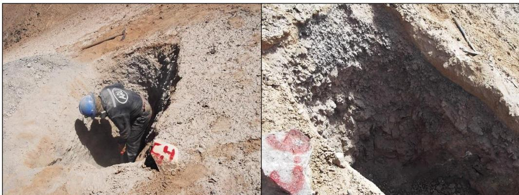
**Fig. 8: Apertura de calicata 1.0x2.0 m<sup>2</sup> a una profundidad de 3 m bajo superficie.**
