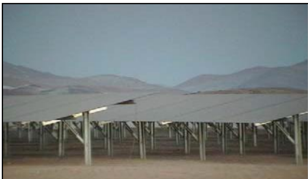
Figura 25: Instalación de módulos fotovoltaicos
