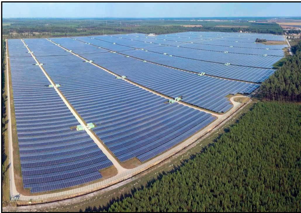
Figura 18: Planta Fotovoltaica de Cestas. 300 MW. Francia.
