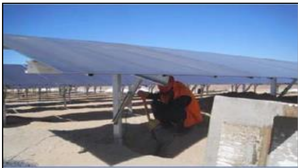
Figura 26: Instalación de módulos fotovoltaicos
