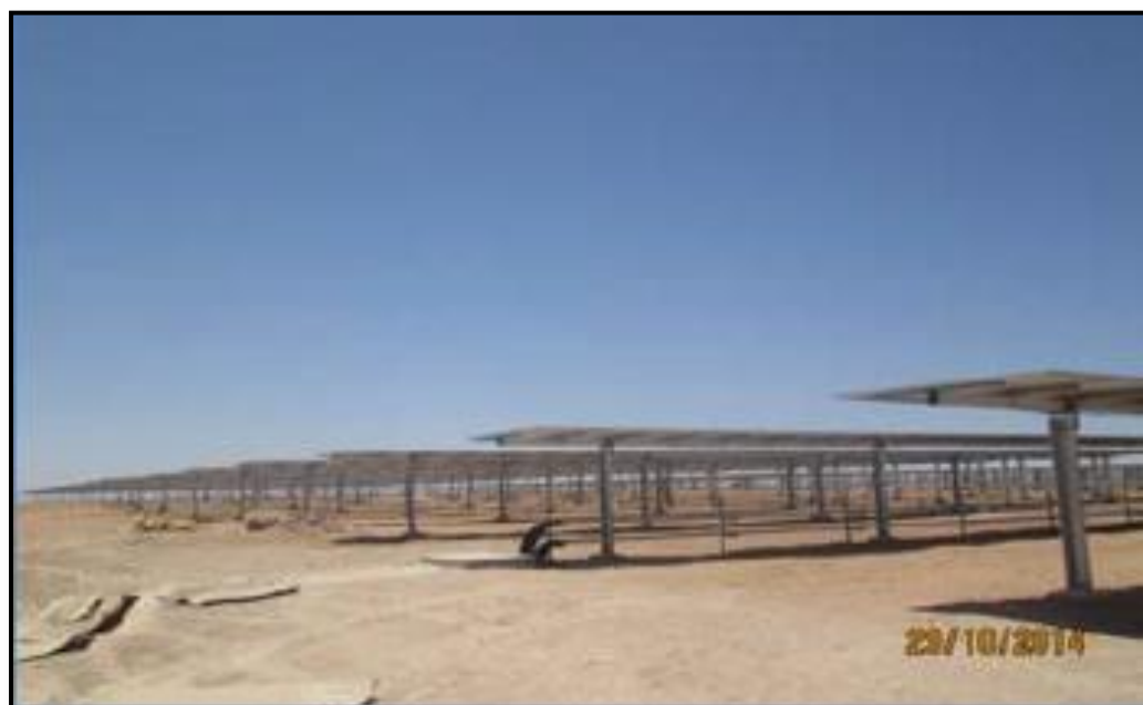
Figura 24: Instalación de módulos fotovoltaicos
