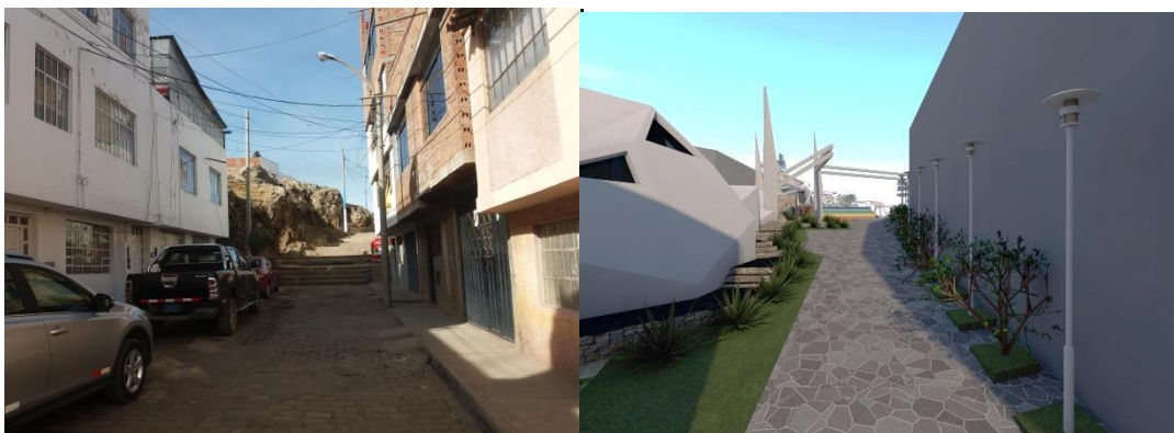
IMAGEN 87: Acceso 1 por Av Circunvalación Sur
