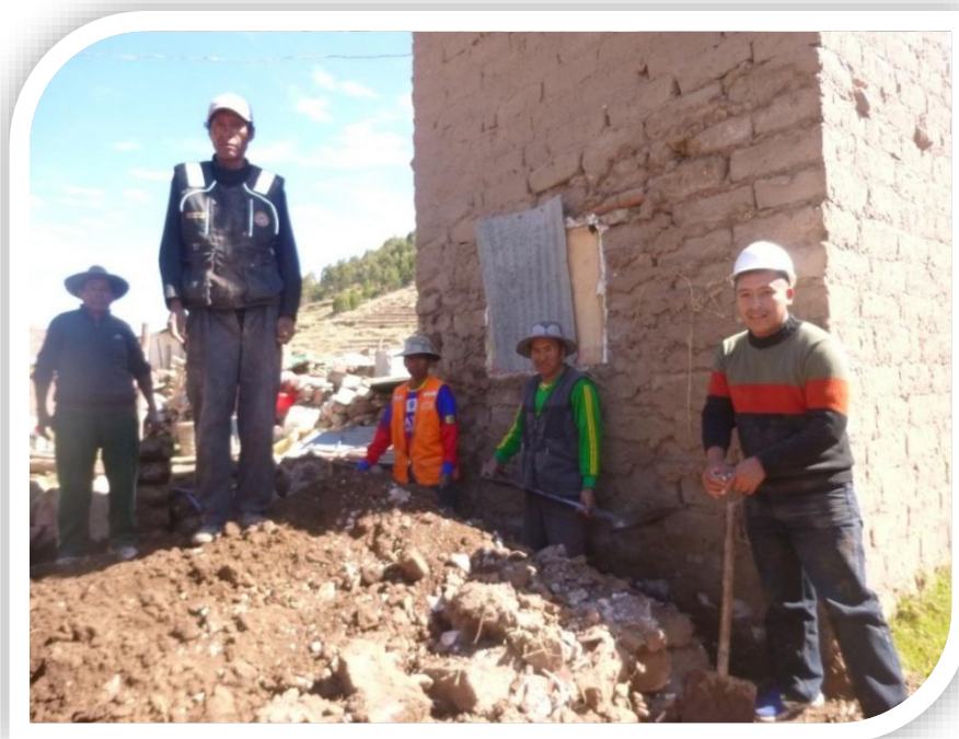
Figura 52: Excavación de zanja para una vivienda
