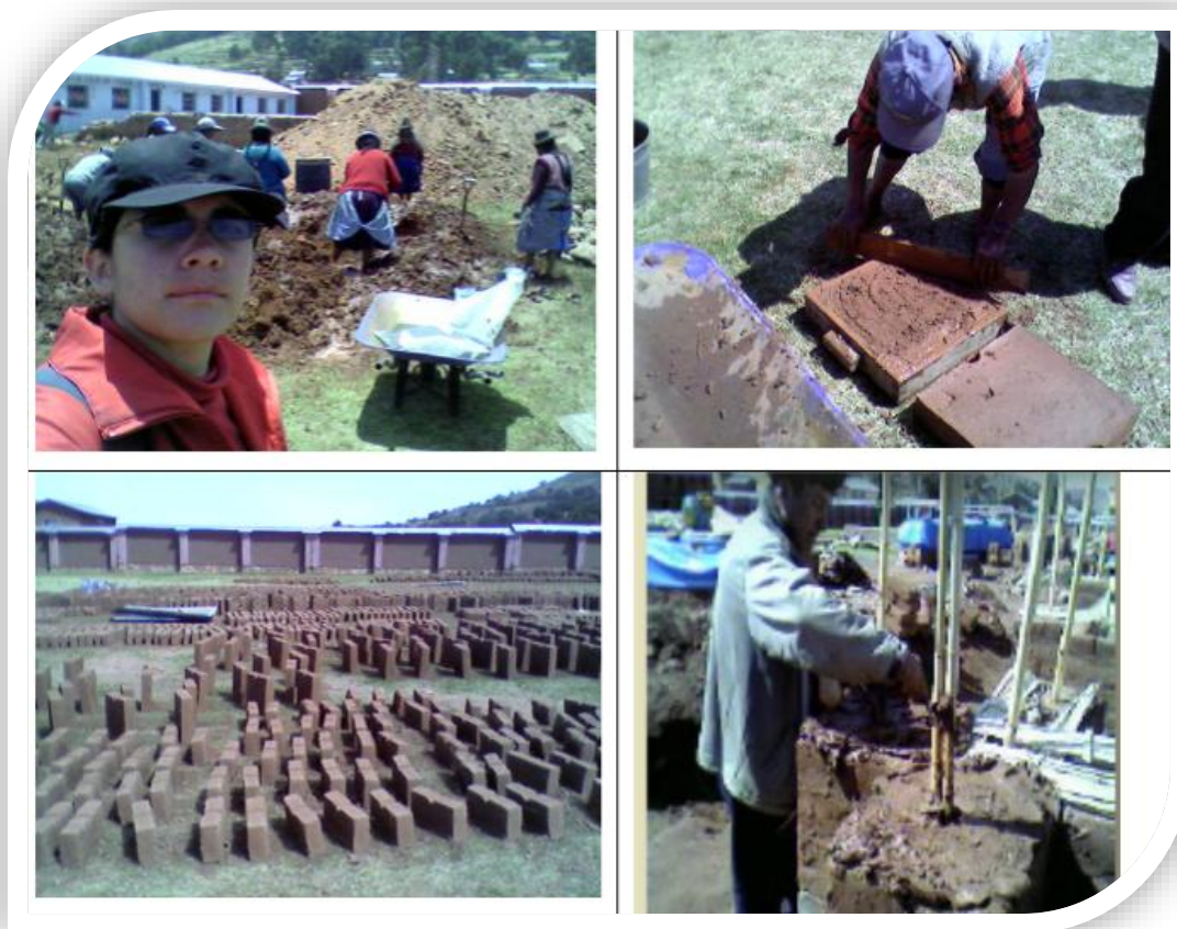
Figura 35: Proceso de elaboración del adobe
