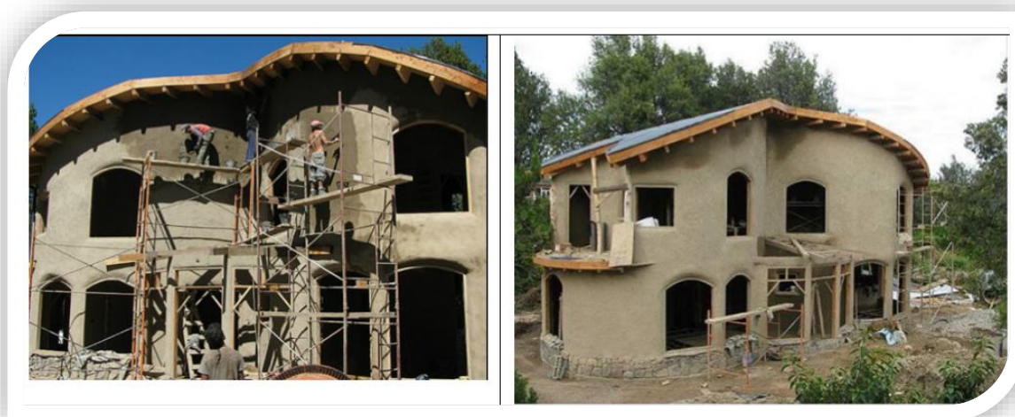
Figura 29: Enlucido de la fachada principal del Maium
