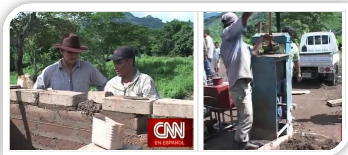
Figura 31: Construcción con adobe en Honduras y la maquina hidráulica
