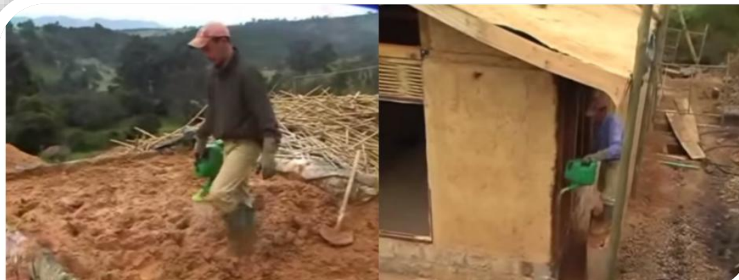
Figura 32: Elaboración de la masa y el enlucido exterior
