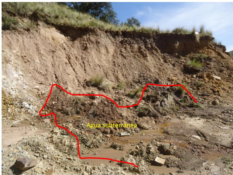
**Figura 23:** En la fotografía se observa material limo arenoso con presencia de agua subterránea en el Km. 10+100 – 10+280.
