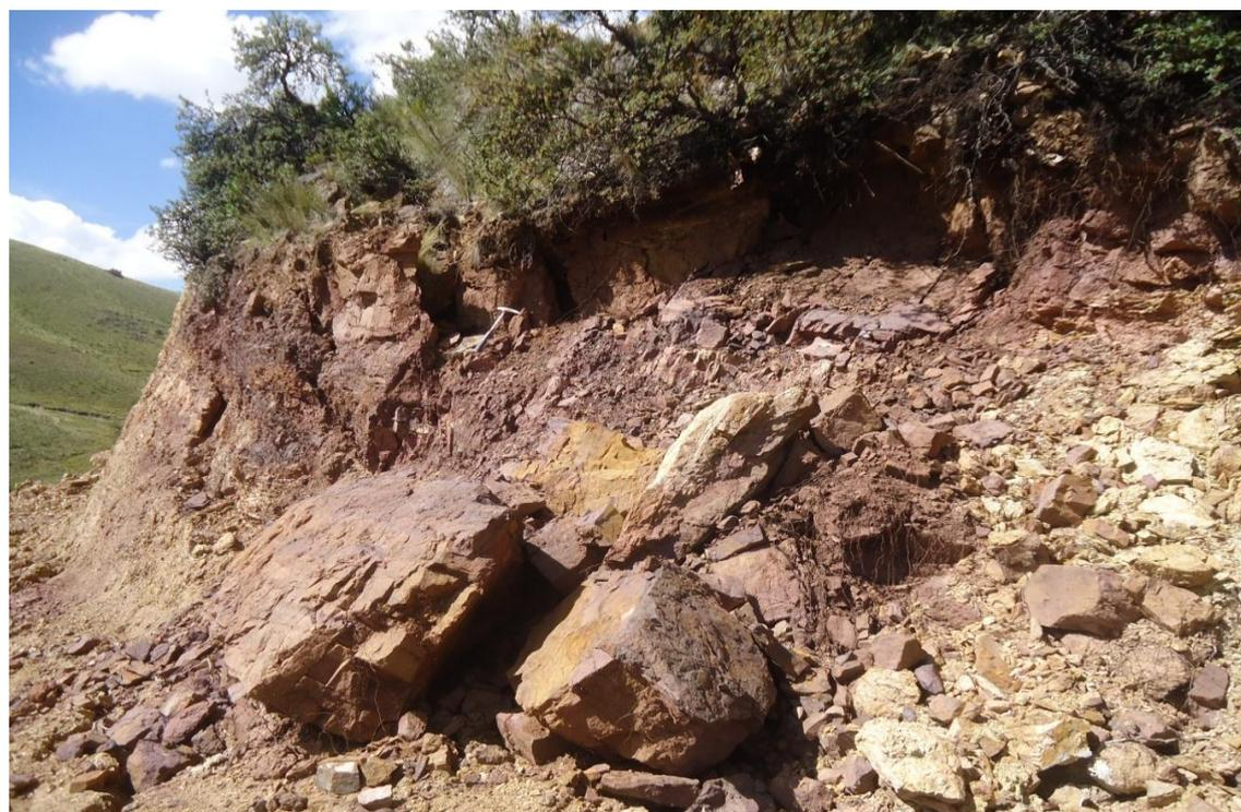
**FOTO N° 08:** Tramo Km. 12+340 – 12+540, talud fallado en suelo residual constituido por limos y arcillas residuales producto de la alteración de las areniscas.
