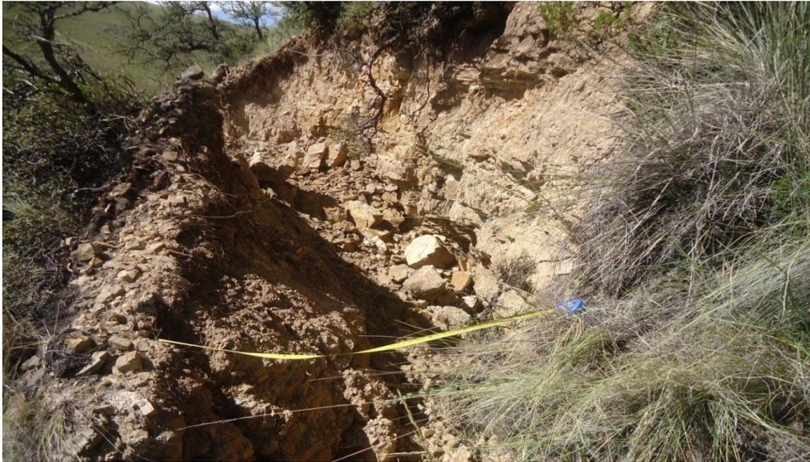
**FOTO N° 09:** Tramo Km. 12+340 – 12+540, se observa grieta de tracción en la cresta del talud superior en suelos residuales areno limo gravoso de color amarillento.
