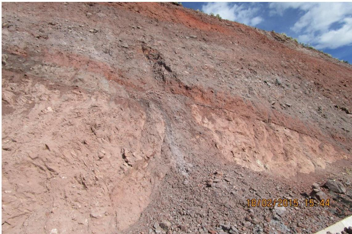
**FOTO N° 10:** Tramo 15+060 – 15+280, talud fallado con superficie de ruptura rotacional superficial en suelos residuales compuesto de material limo arenoso con grava de color pardo rojizo del Grupo Mitu.
