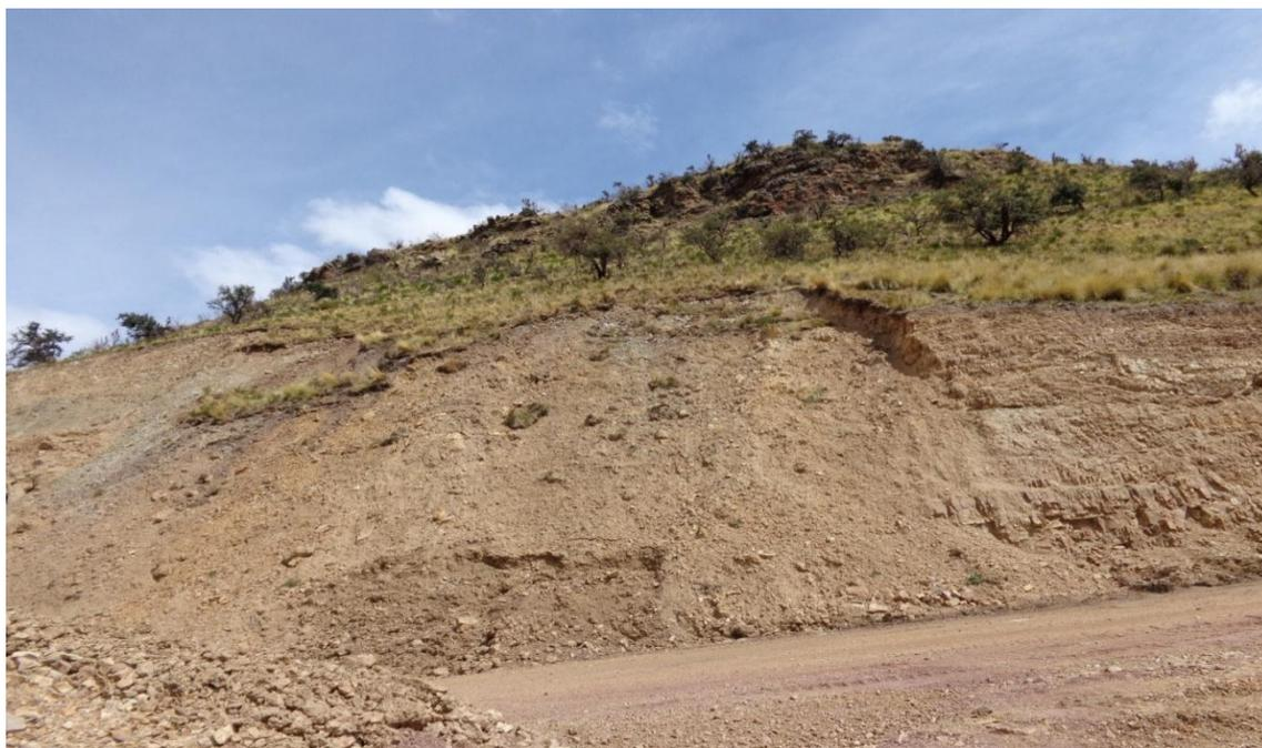
**FOTO N° 07:** Tramo Km. 12+000 – 12+160, falla del talud con superficie de ruptura rotacional en suelo limo arcilloso residual con grava debido a la saturación del material de color amarillento de la Formación Lampa.
