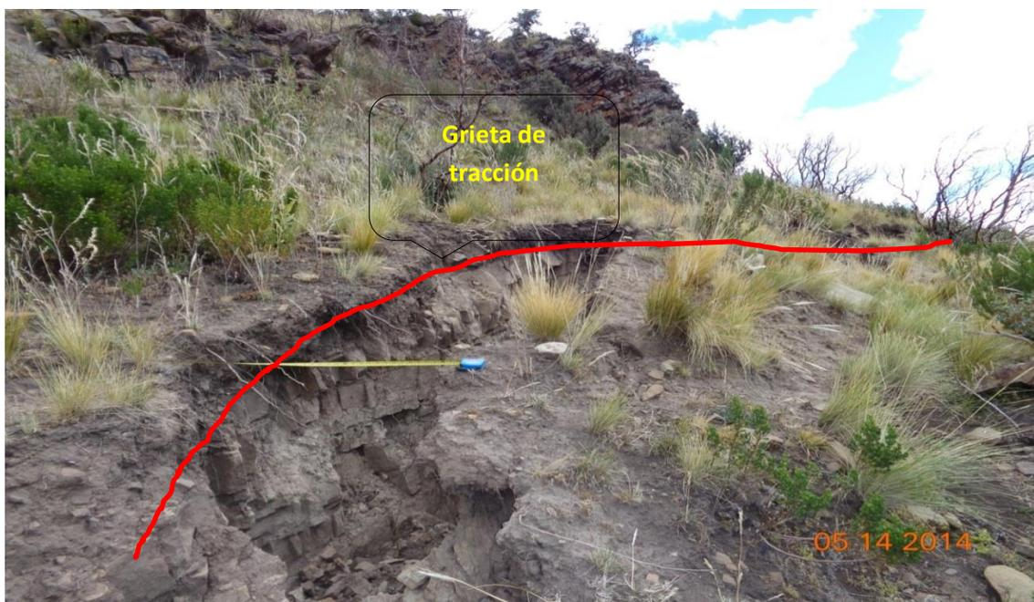
**FOTO N° 06:** Tramo Km. 12+000 – 12+160, se observa grieta de tracción en la cresta del talud superior en suelos residuales compuesto de material areno limo con grava de color pardo grisáceo. Medida del ancho de la fractura.
