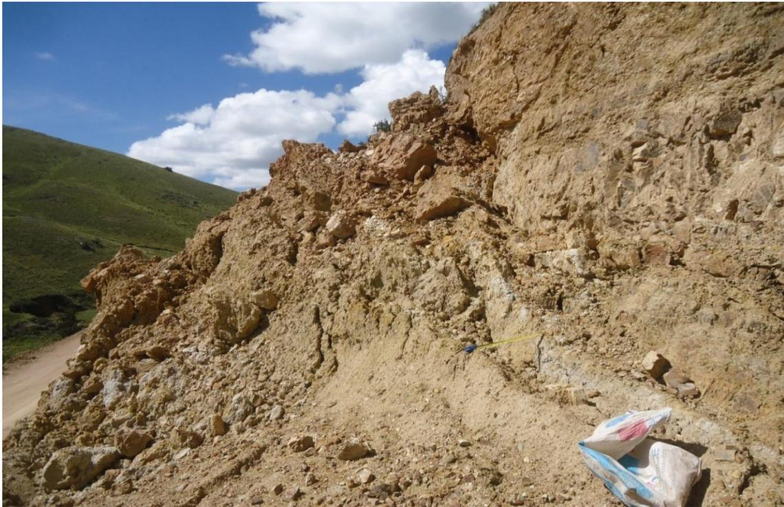
**FOTO N° 13:** Tramo Km. 17+680 – 18+000, falla del talud con superficie de ruptura circular en suelo residual comprometiendo la banquetta de estabilización de material grava limo arcilloso de color gris amarillento.
