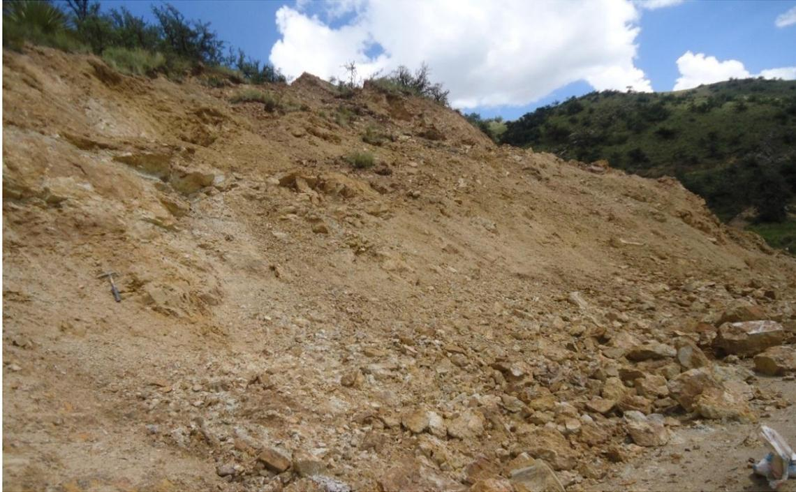
**FOTO N° 01:** Tramo Km. 10+360 – 10+660, talud fallado en suelo residual, constituido mayormente de arcillas gravosas de color amarillento.
