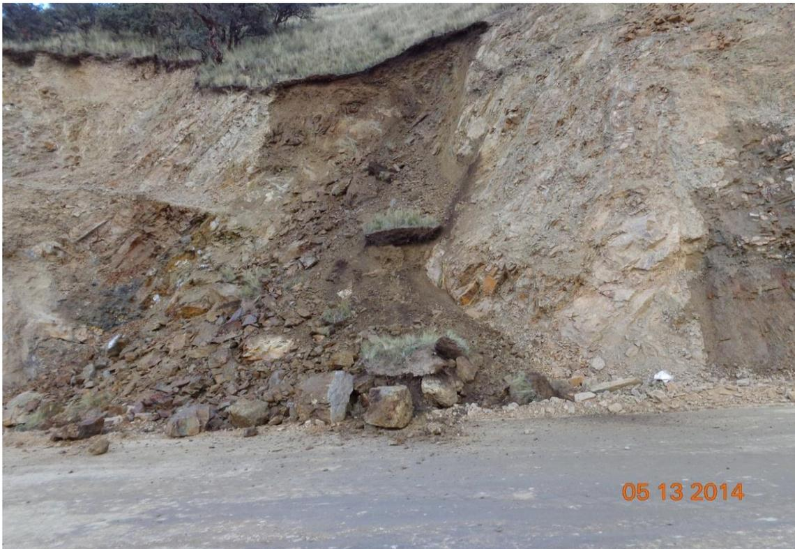
**FOTO N° 02:** Tramo Km. 10+360 – 10+660, talud fallado en suelos residuales areno limo gravoso de color pardo amarillento de la Formación Lampa.
