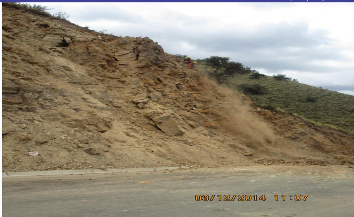
**FOTO N° 11:** Tramo Km. 15+440 – 15+540, talud fallado con superficie de ruptura rotacional en suelos limo arcillosos con grava arcilloso residual con bloques de piedra.
