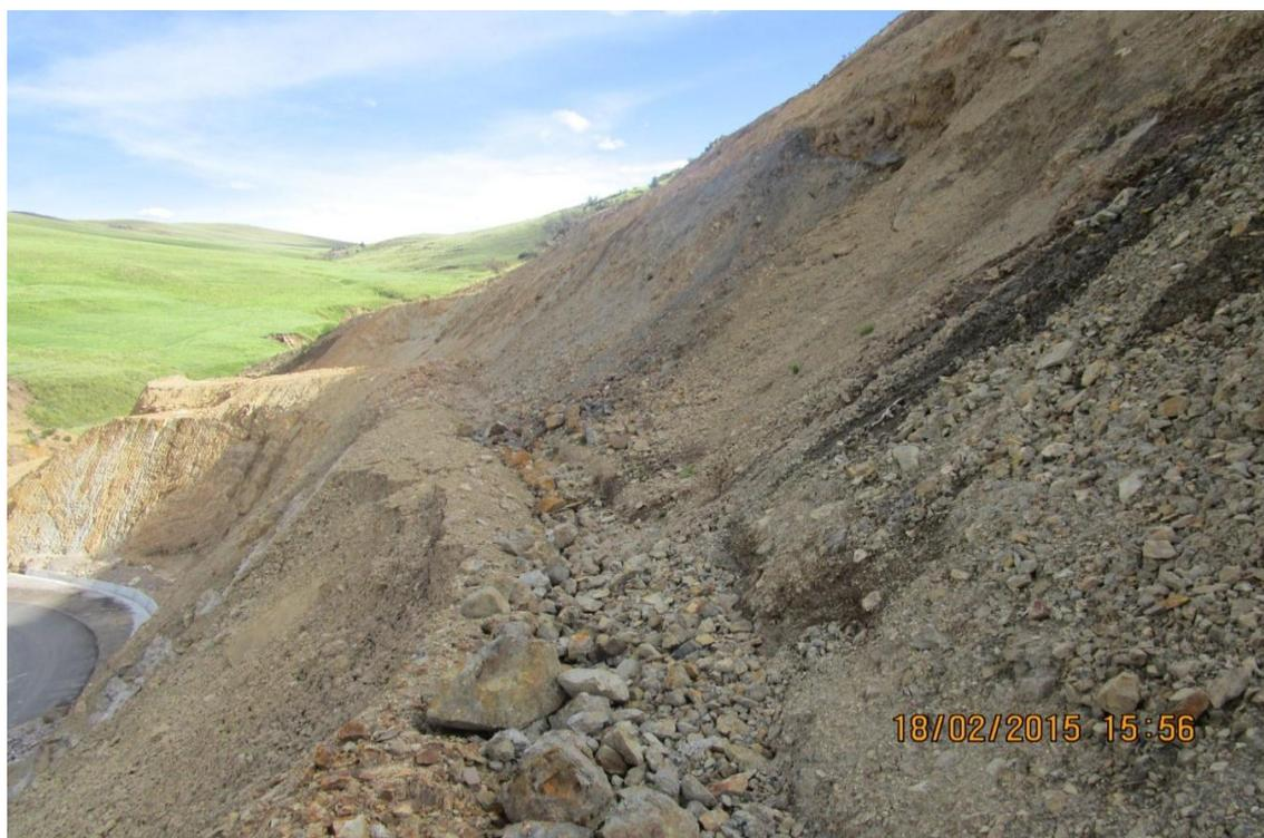
**FOTO N° 04:** Tramo Km. 12+000 – 12+160, falla del talud comprometiendo la banqueta de estabilización en suelo residual grava arcilloso de color pardo amarillento de la Formación Lampa.
