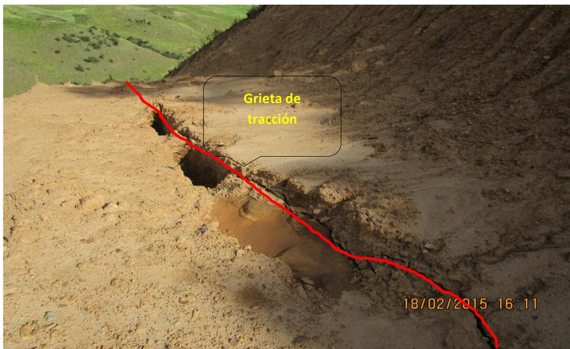
**FOTO N° 05:** Tramo Km. 12+000 – 12+160, falla del talud en suelo residual donde se observa la generación de grietas de tracción comprometiendo la banqueta de estabilización, debido a la saturación del material grava arcilloso de color amarillento.
