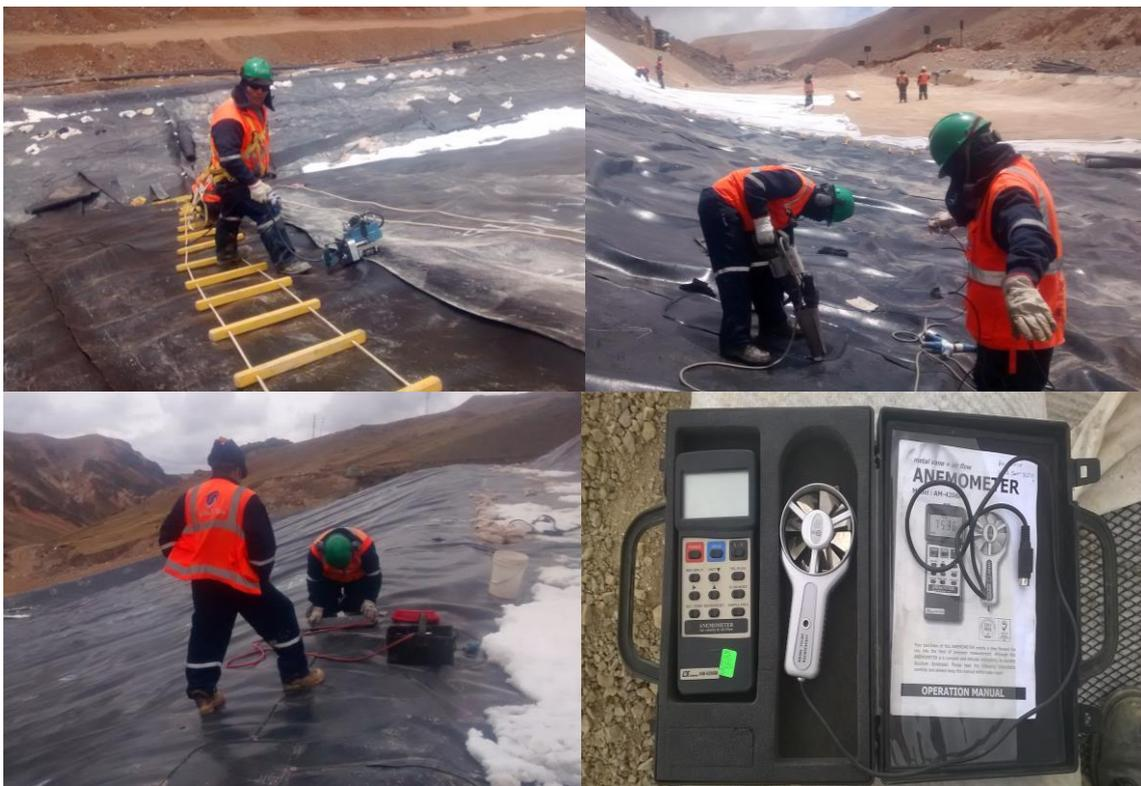
Figura N° 26. Equipos para la instalación de geosintéticos para la construcción del PAD,
