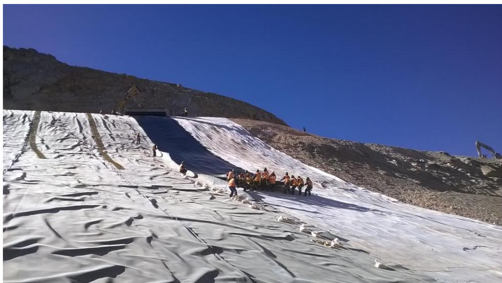
Figura N° 22. En la foto se observa el extendido de geomembrana para la construcción del PAD, Fuente: Propia
