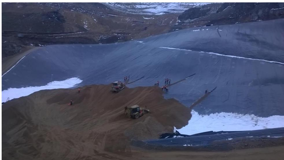
Figura N° 24. En la foto se observa el sobre-revestimiento de Over Line para la construcción del PAD, Fuente: Propia
