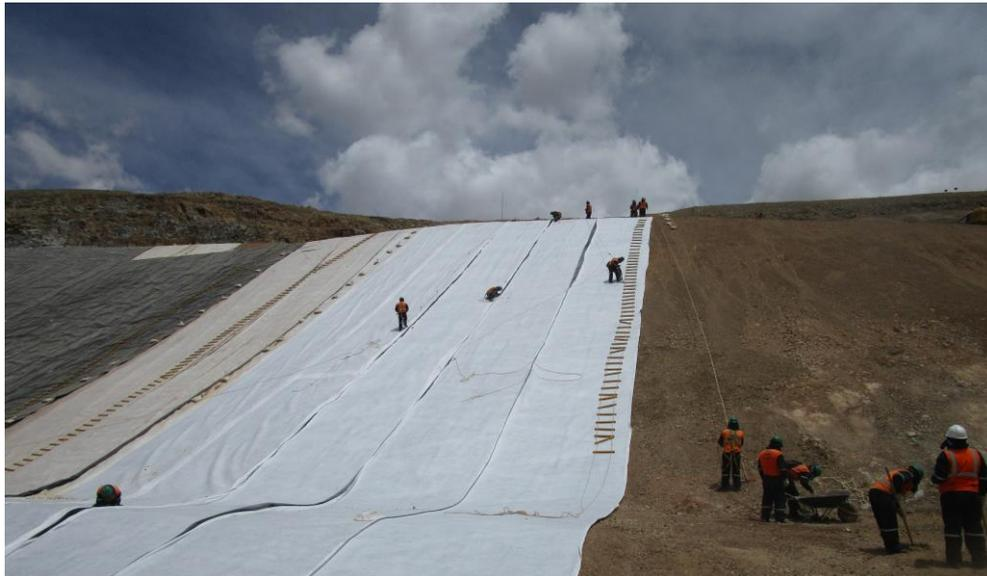
Figura N° 20. En la foto se observa el extendido de geocompuesto para la construcción del PAD, Fuente: Propia
