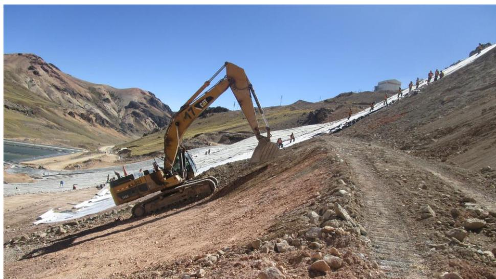
Figura N° 19. En la foto se observa el perfilado de la cimentación para la construcción del PAD, Fuente: Propia
