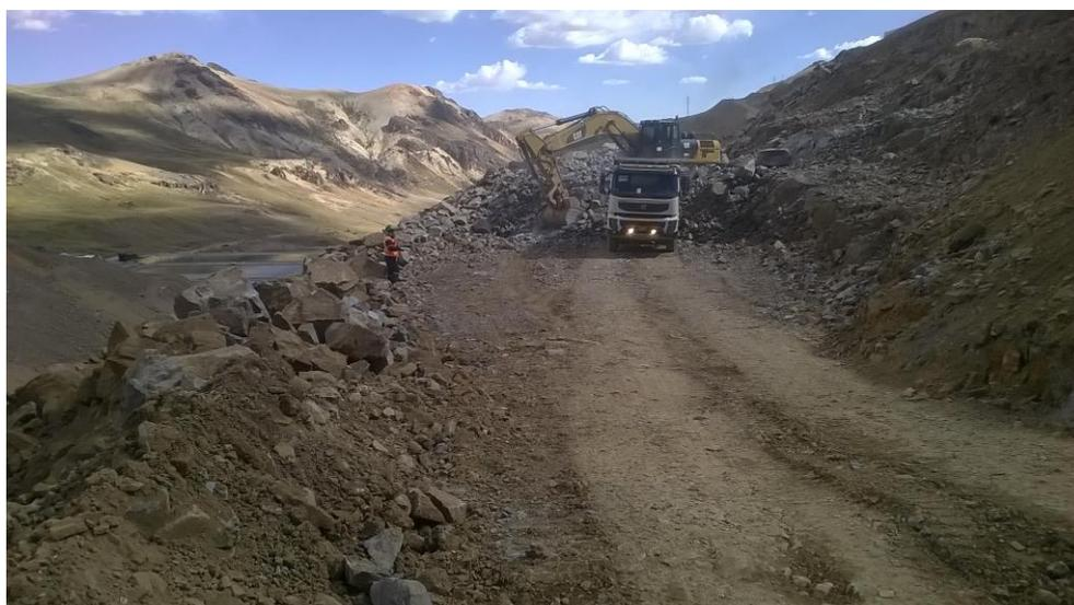
Figura N° 17. En la foto se observa la eliminación de roca suelta producto de la voladura para la construcción del PAD, Fuente: Propia
