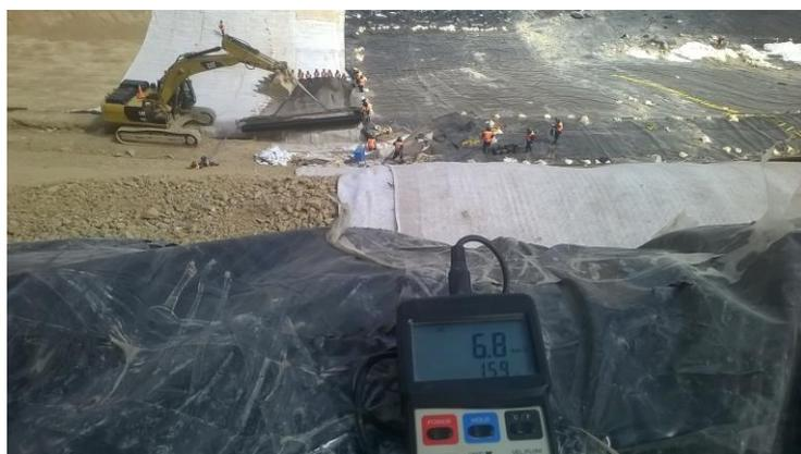
Figura N° 37. Uso del anemómetro durante el despliegue de geomembrana, Fuente: Propia
