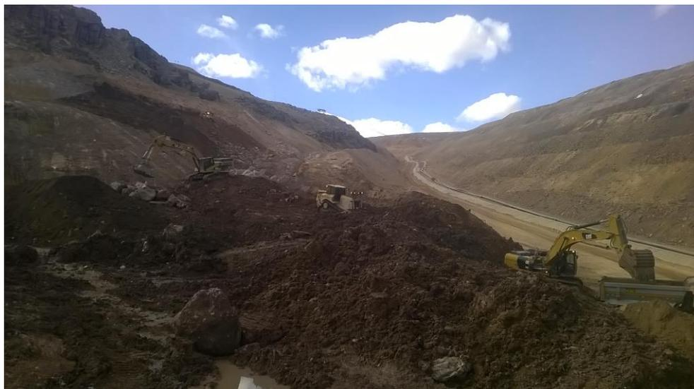
Figura N° 16. En la foto se observa la eliminación de material inadecuado (Top Soil, Peat) para la construcción del PAD, Fuente: Propia
