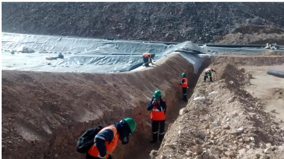
Figura N° 25. En la foto se observa la excavación de trincheras de anclaje para los geosintéticos para la construcción del PAD, Fuente: Propia
