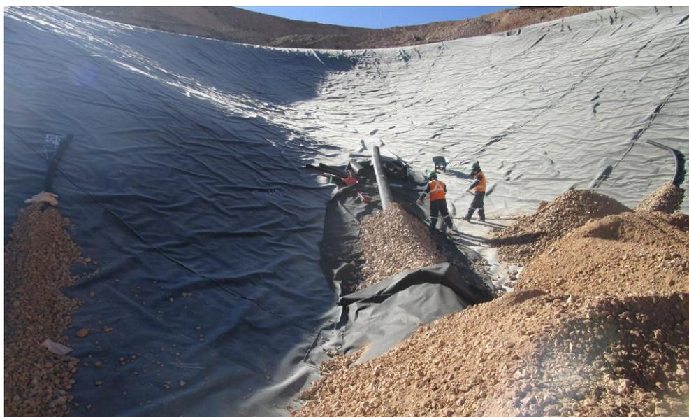
Figura N° 23. En la foto se observa la instalación de tuberías de colección para la construcción del PAD, Fuente: Propia
