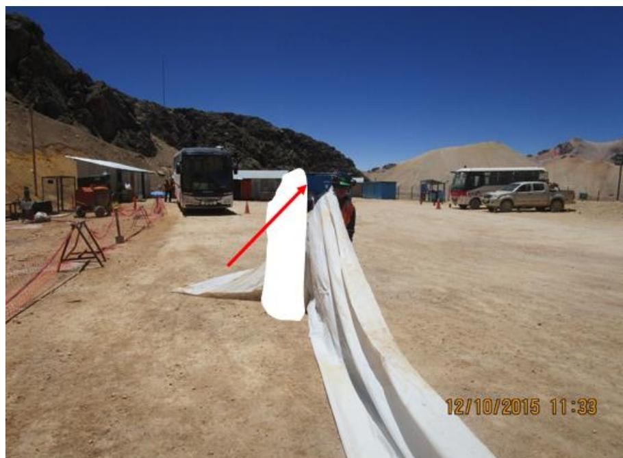
**Fig. (6) El GCL golpea el hombro del trabajador, éste se arrodilla para evitar mayor daño**
