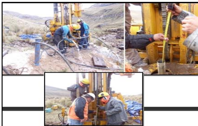
Figura N° 47. : Ensayos de permeabilidad tipo Lefranc (fuente: propia).
