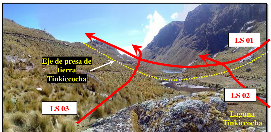
Figura N° 38. : Fotografía del eje de la presa y disposición de líneas sísmicas (fuente: propia).
