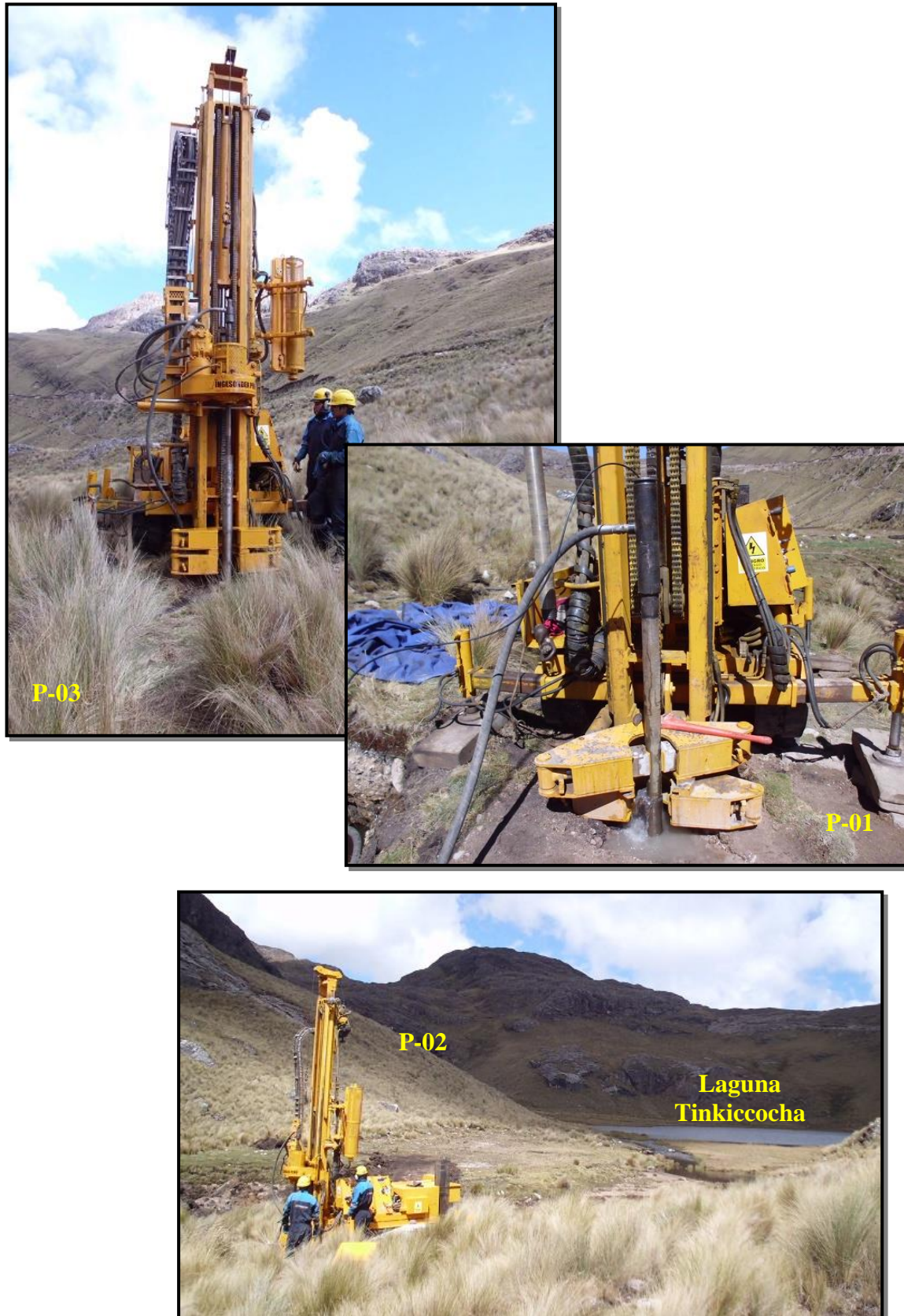
Figura N° 44. : Perforaciones diamantinas en la zona de investigación (fuente: propia).
