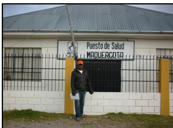
FOTO N° 02: En la imagen se aprecia el Puesto de Salud del C.P. Maquercota.
