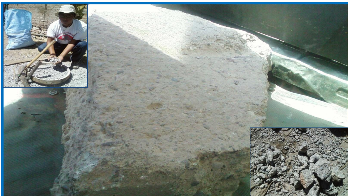
FOTO N° 02: BLOQUE DE PAVIMENTO RIGIDO SELECCIONADO PROVENIENTE DEL JR. APURIMAC CUADRAS 1-2 DE LA CIUDAD DE JULIACA.
