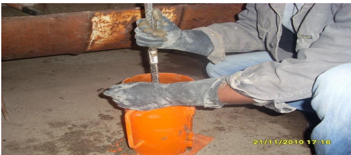
Foto Nº 06: Colocación del Concreto fresco en las probetas.
