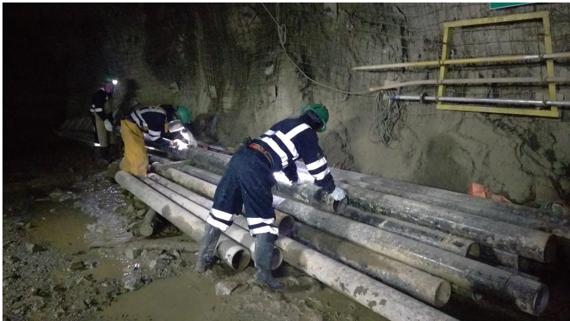
FOTO. 7: cortado y biselado de la tubería a SCH80 de 8”
