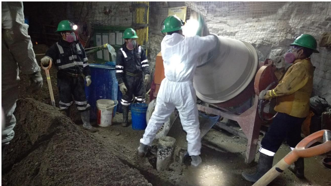
FOTO. 8: vaciado de mortero de taladro
