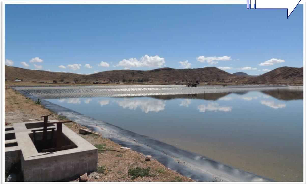
**Vista 01.** Sistema de Lagunas de estabilización distribuidas en Paralelo.
