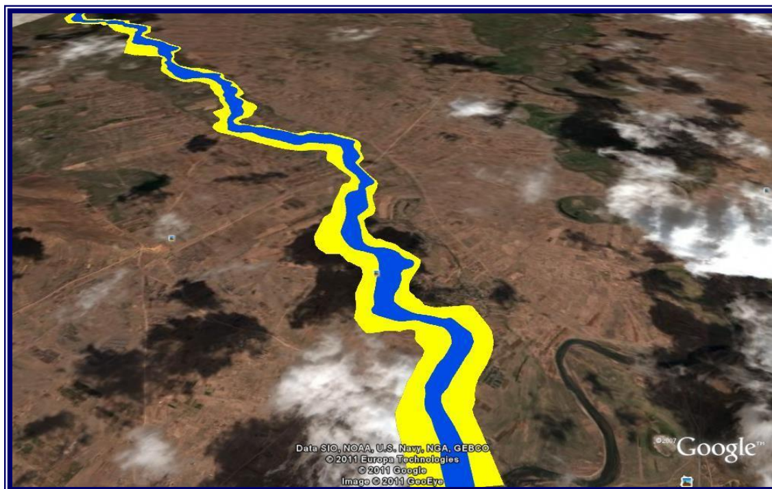
FOTO N° 05: VISTA DE LAS ÁREAS INUNDABLES EN LA PARTE BAJA DEL RÍO CABANILLAS.
