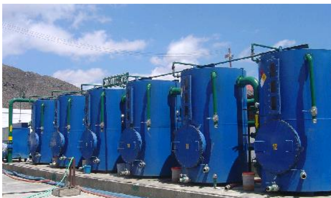
Figura 4: Planta de adsorción con tanques cerrados
