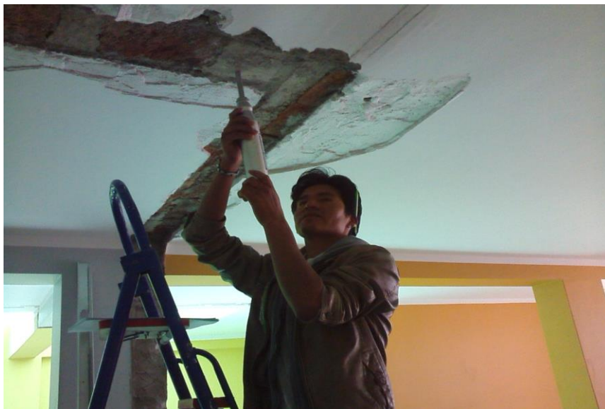
Figura N°09: Ensayos no destructivos con esclerómetro – Puno - LOSA
