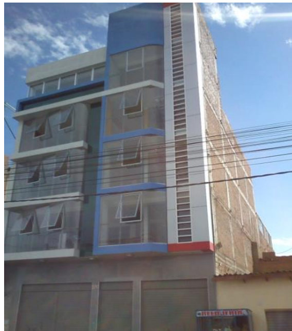
Figura N°07: Vista edificación existente Puno
