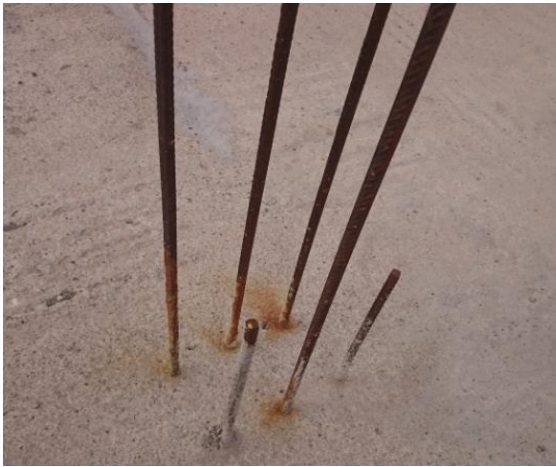
Figura N°04: Acero en Columnas 6Ø1/2" Azotea
