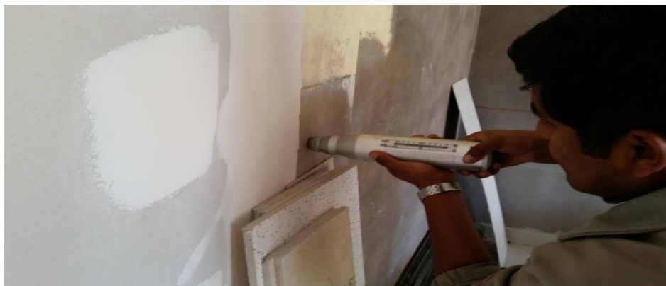
Figura N°08: Pruebas con Esclerómetro en Columnas
