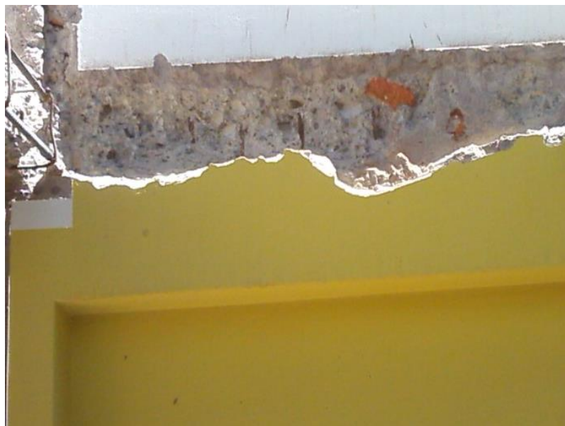
Figura N°11: Picado en Viga de 30x40 cm, Caja Arequipa – Puno Cuarto Nivel
