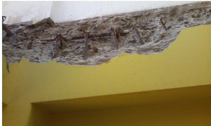
Figura N°10: Picado en Viga de 30x40 cm, Caja Arequipa – Puno Cuarto Nivel
