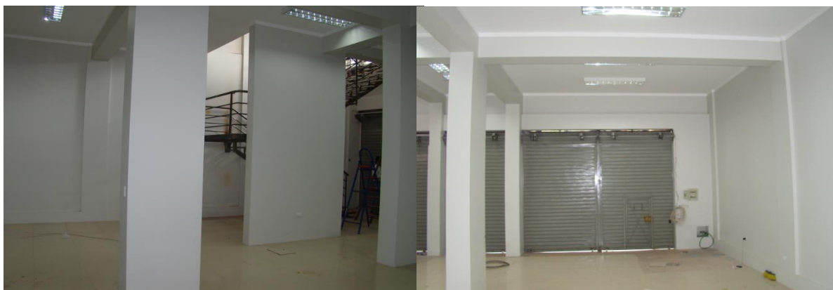
Figura N°01: Pórticos de primer nivel Columnas
