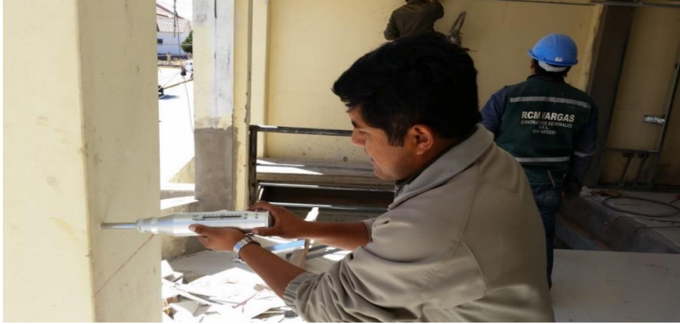
Figura N°06: Pruebas con Esclerómetro en Columnas
