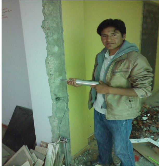
Figura N°8: Ensayos no destructivos con esclerómetro – Puno - Columnas
