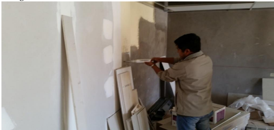
Figura N°07: Pruebas con Esclerómetro en Columnas
