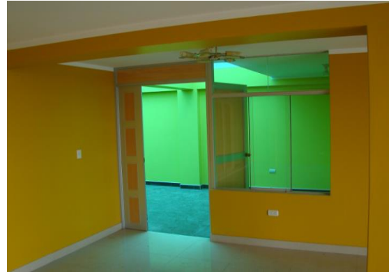
Figura N°04: Estado de las estructuras Cuarto Nivel
