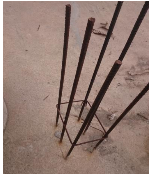
Figura N°05: Acero en Columnas 6Ø1/2" Azotea
