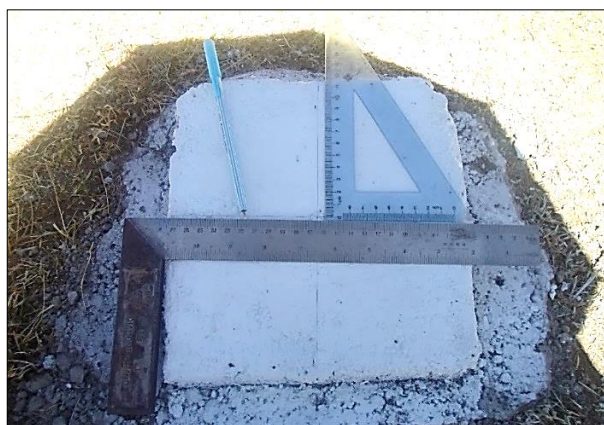
Figura 44. Trazo y control de la línea eje con apoyo de escuadras. Fuente: Elaboración Propia.
