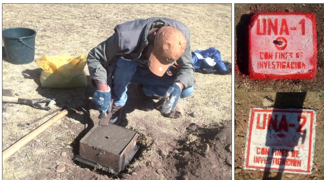
Figura 30. Monumentación de los puntos UNA-1 y UNA-2. Fuente: Elaboración Propia.
