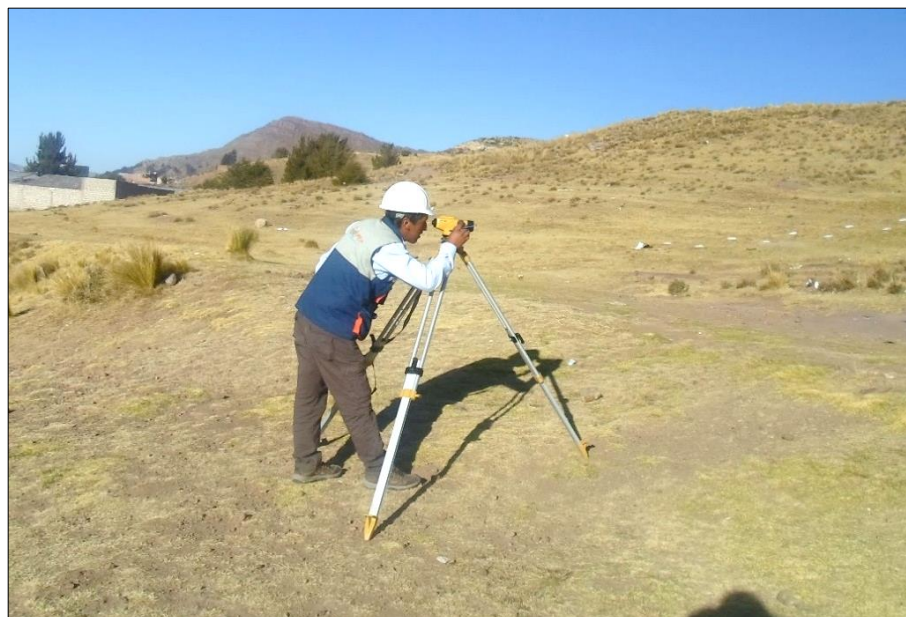
Figura 36. Nivelación compuesta de la poligonal con el nivel de ingeniero AT-B3. Fuente: Elaboración Propia.
