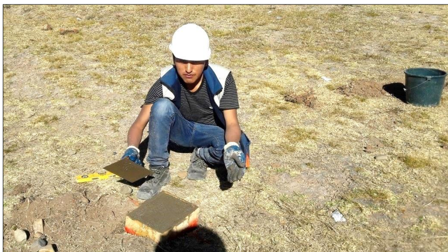
Figura 41. Monumentación de puntos de T-01 al T-18 de dimensiones 22 x 22 cm. Fuente: Elaboración Propia.
