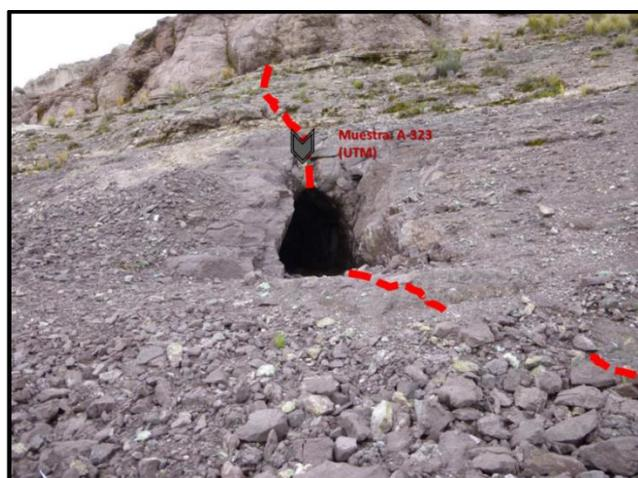
**Figura 30:** Veta 3 rellena en Fractura, espesor de 20 cm, se muestra labor minera artesanal.
