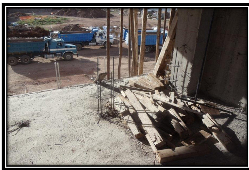
Figura N° 62: Volquetes para el retiro de material excedente en Complejo Deportivo Universitario
