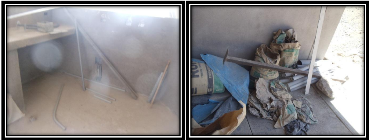
Izquierda: Tubos de PVC en interior 1er nivel sector “D” estar médico Mega Laboratorio Clínico
