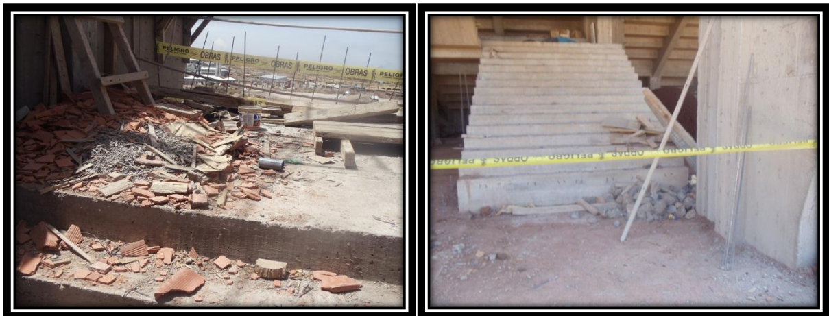
Izquierda: Material de escombros en descanso escaleras 3er nivel Tribuna Oriente Complejo Deportivo Universitario
