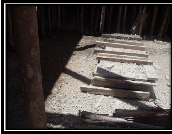
Izquierda: Encofrado no reutilizable en interior 2do nivel Tribuna Sur Complejo Deportivo Universitario
