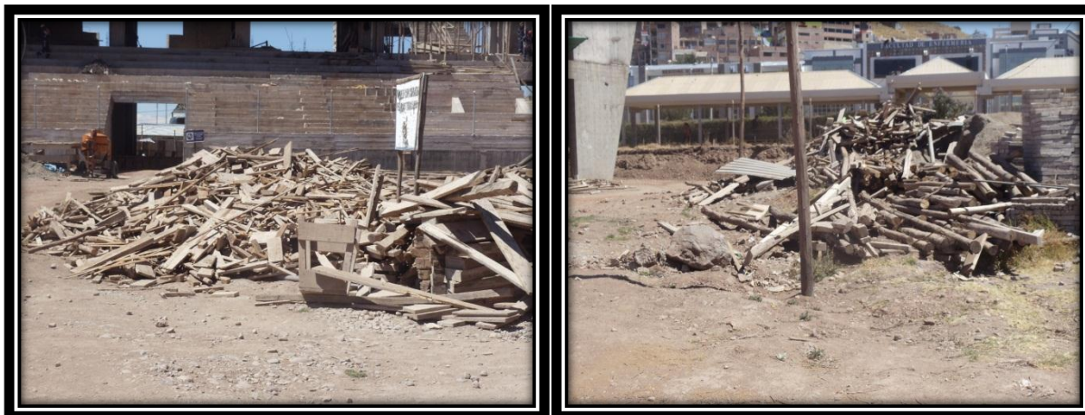
Izquierda: Retazos de madera en el centro de campo de obra Complejo Deportivo Universitario
