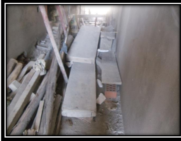
Izquierda: Encofrados no reutilizables en interior ambiente sector “F” Mega Laboratorio Clínico
