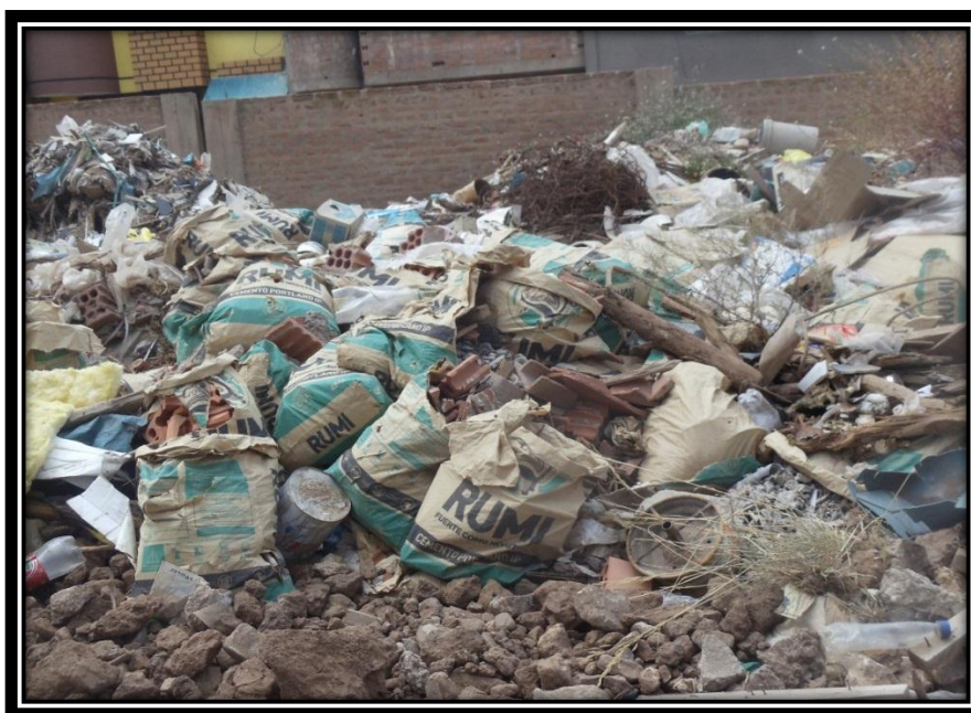
Figura N° 9: Acumulación de desperdicios debido a falta de supervisión en Mega Laboratorio Clínico
