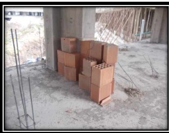
Izquierda: Ladrillos huecos para aligerado inservibles en campo de obra Complejo Deportivo Universitario
