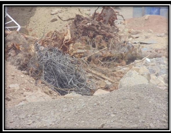
Izquierda: Alambres para encofrado inservibles en campo de obra costado del sector “F” Mega Laboratorio Clínico
