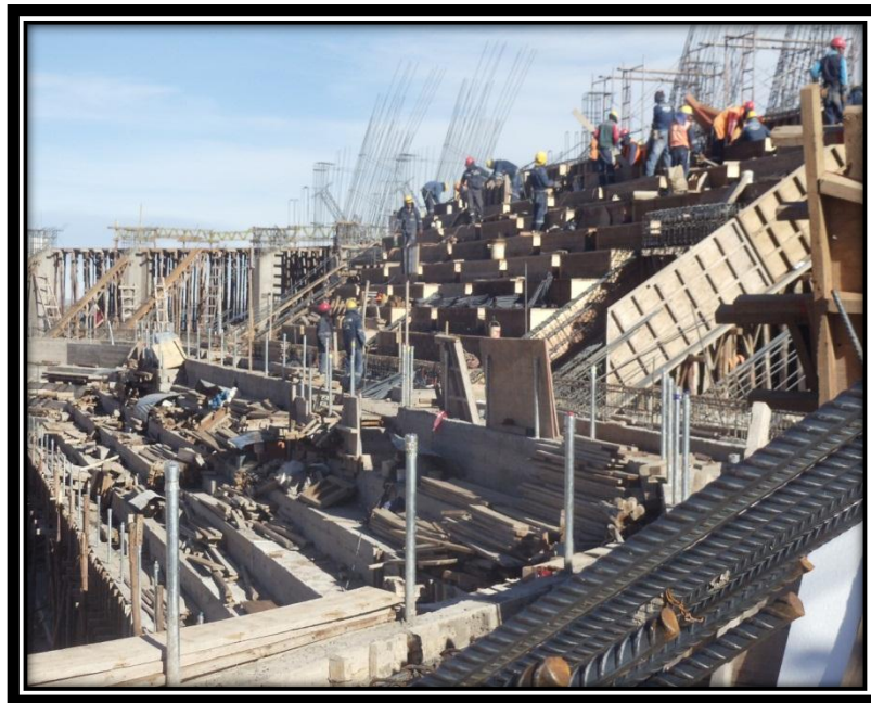
Figura N° 10: Sistema de encofrados de madera en Complejo Deportivo Universitario
