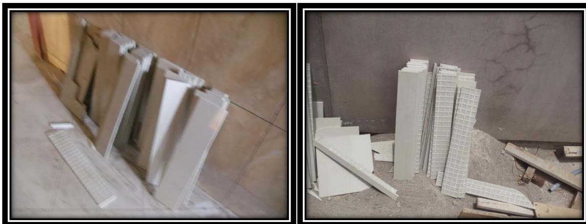
Izquierda: Cerámicos para piso inservibles en interior 1er nivel corredor entre sectores “D” y “E” Mega Laboratorio Clínico
