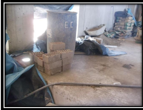
Izquierda: Ladrillos King Kong para albañilería inservibles en interior ambiente almacén sector “F” Mega Laboratorio Clínico
