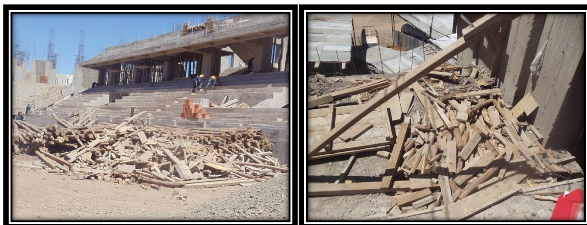
Izquierda: Retazos de madera en campo de obra en frente de Tribuna Occidente Complejo Deportivo Universitario
