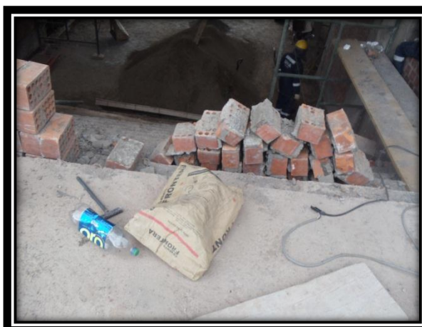
Izquierda: Ladrillos King Kong para albañilería inservibles en escaleras de acceso a graderío bajo Tribuna Occidente Complejo Deportivo Universitario
