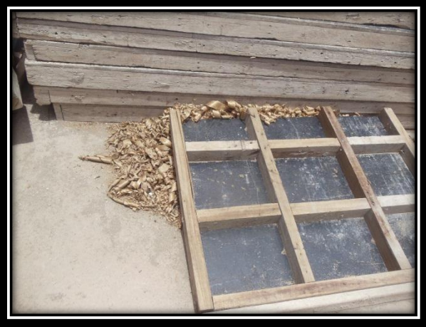
Izquierda: Encofrados no reutilizables en interior ambiente sector “F” Mega Laboratorio Clínico
