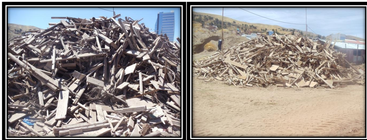
Izquierda: Retazos de madera en campo de obra costado taller de carpintería vista lateral Complejo Deportivo Universitario
