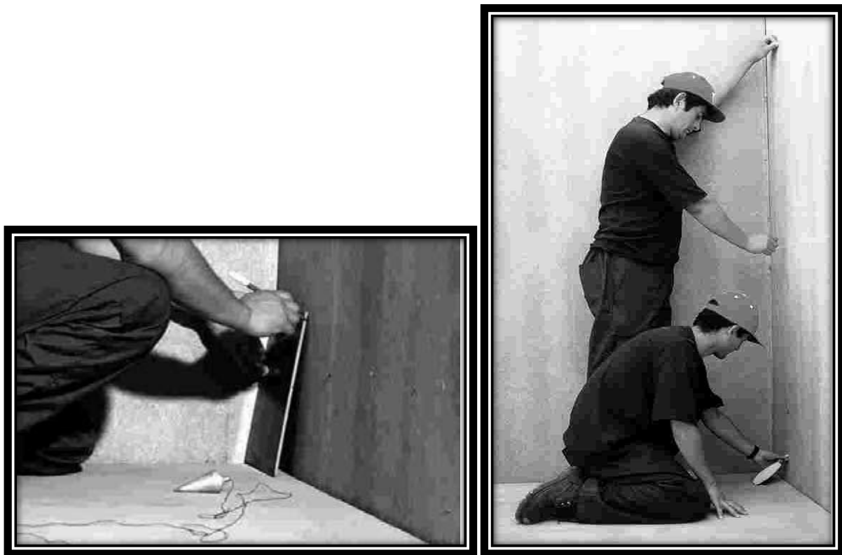
Figura N° 31: a) Izquierda: Colocado de palmetas en el muro. b) Derecha: Medición para el encuadrado de las palmetas.
