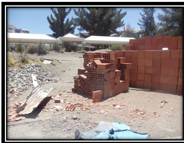
Izquierda: Ladrillos huecos para aligerado inservibles en campo de obra Complejo Deportivo Universitario
