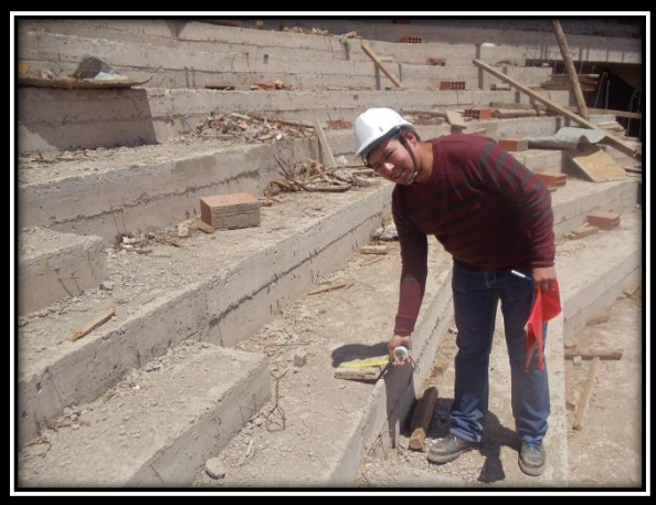
Izquierda: Ladrillos King Kong para albañilería inservibles en 1er nivel escaleras de acceso a graderío bajo Tribuna Oriente Complejo Deportivo Universitario
