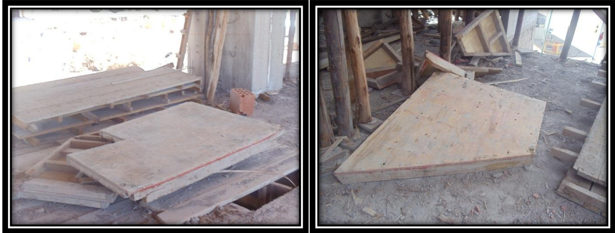
Izquierda: Encofrados rectangulares no reutilizables en 2do nivel Tribuna Oriente Complejo Deportivo Universitario
