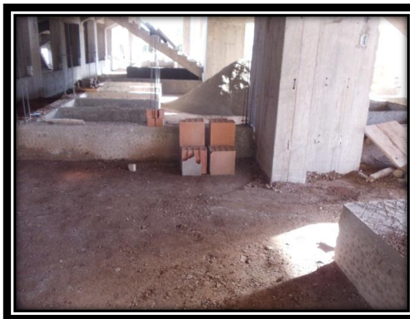
Izquierda: Ladrillos huecos para aligerado inservibles en interior 1er nivel Tribuna Occidente Complejo Deportivo Universitario
