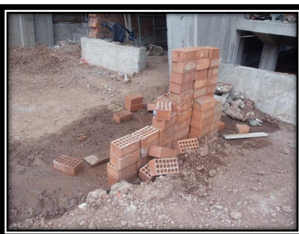
Izquierda: Ladrillos King Kong para albañilería inservibles en escaleras de acceso a graderío bajo Tribuna Occidente Complejo Deportivo Universitario
