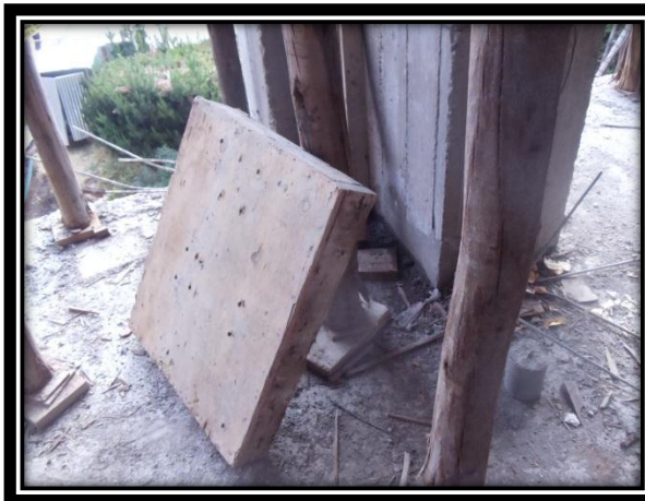
Izquierda: Encofrado no reutilizable en interior 2do nivel Tribuna Occidente Complejo Deportivo Universitario
