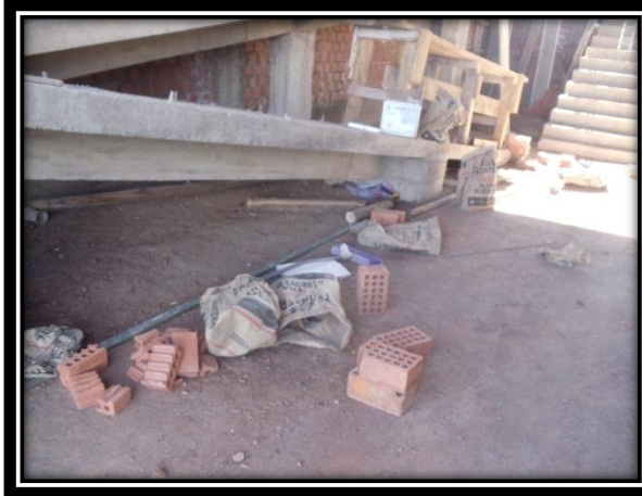
Izquierda: Ladrillos King Kong para albañilería inservibles en 1er nivel escaleras de acceso a graderío bajo Tribuna Oriente Complejo Deportivo Universitario
