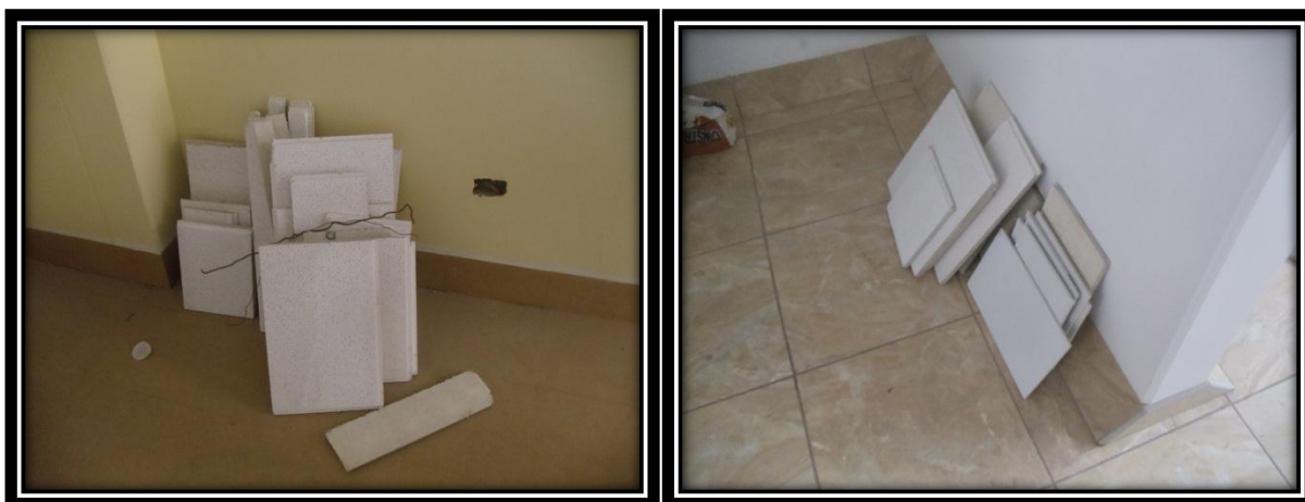
Izquierda: Superboard para cielorraso inservible en interior 1er nivel sector "E" Mega Laboratorio Clínico
