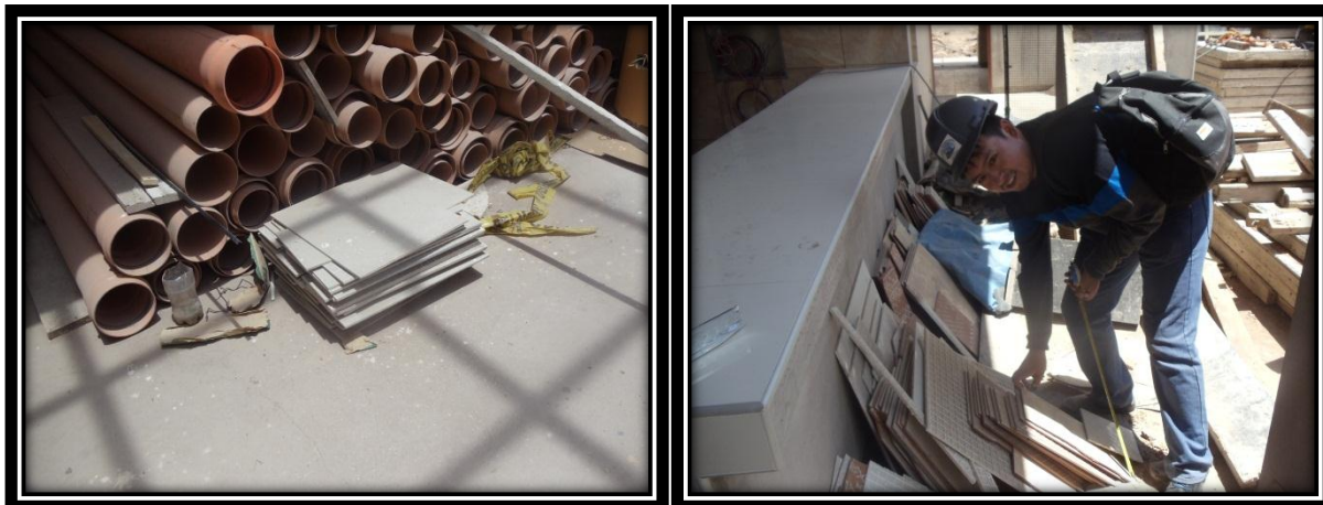
Izquierda: Porcelanatos para piso inservibles en interior 1er nivel sector "A" Mega Laboratorio Clínico
