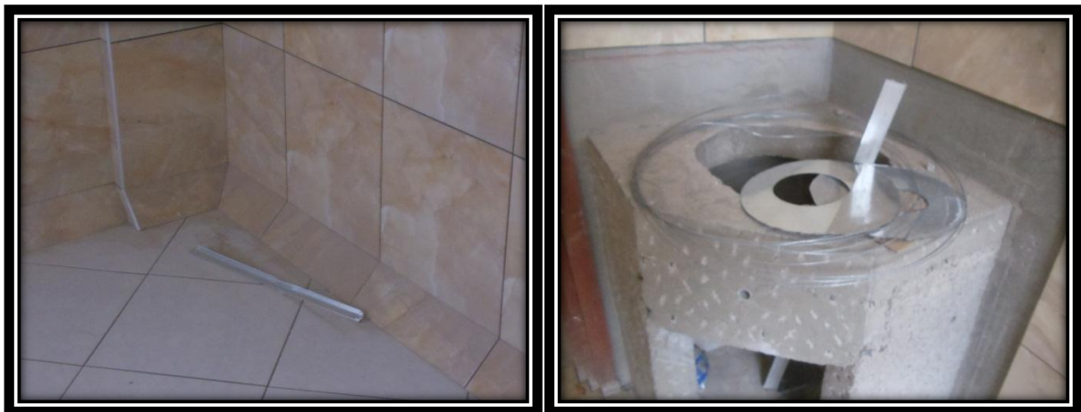
Izquierda: Perfiles para cielorraso en interior 1er nivel sector "D" Mega Laboratorio Clínico
