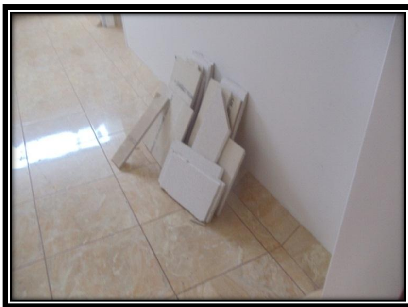
Figura N° 45: Superboard para cielorraso inservible
