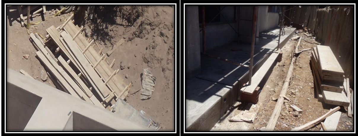
Izquierda: Encofrados no reutilizables en campo de obra frente a salón de grados Escuela Profesional de Trabajo Social
