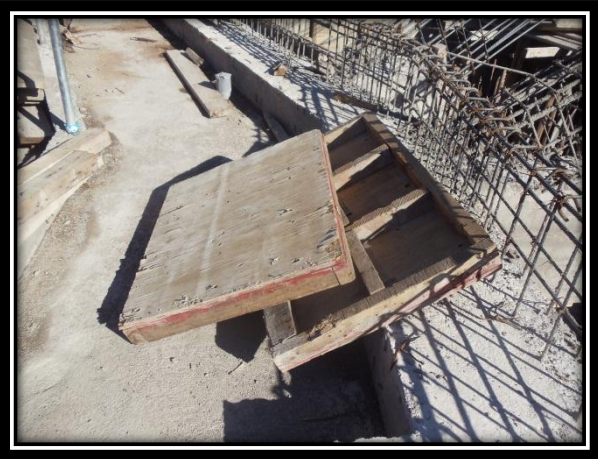
Izquierda: Encofrado no reutilizable en interior 2do nivel Tribuna Sur Complejo Deportivo Universitario
