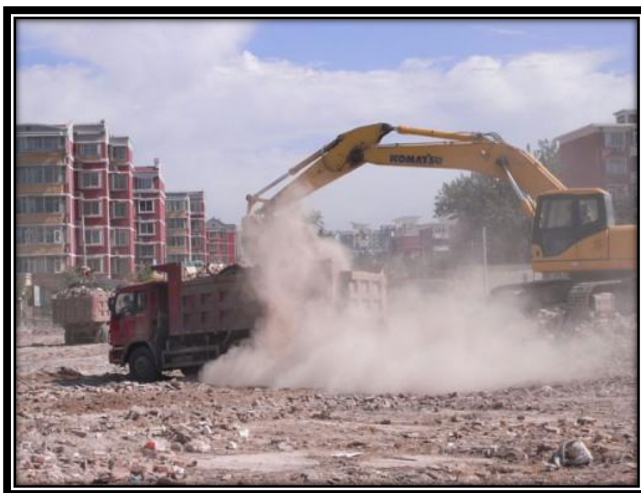
Figura N° 35: Contaminación del aire por actividades de construcción
