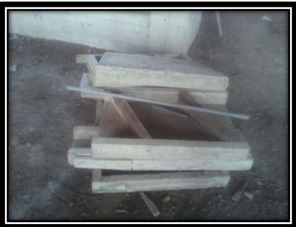
Izquierda: Encofrado no reutilizable en interior 2do nivel Tribuna Occidente Complejo Deportivo Universitario
