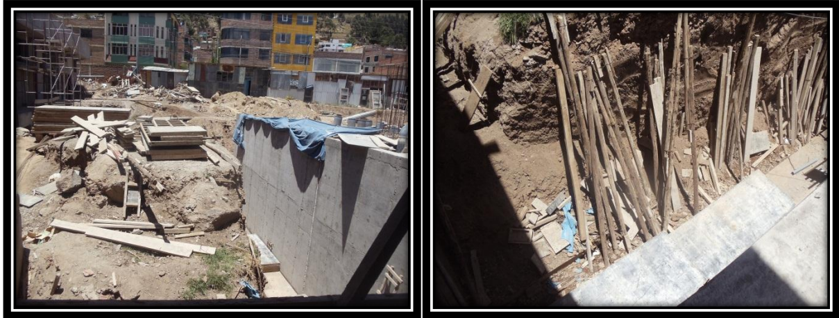
Izquierda: Encofrado no reutilizable en campo de obra sector “F” muro de contención Mega Laboratorio Clínico
