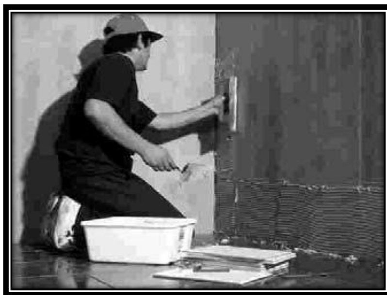
Figura N° 32: Colocación de adhesivo rígido en muros para el cerámico
