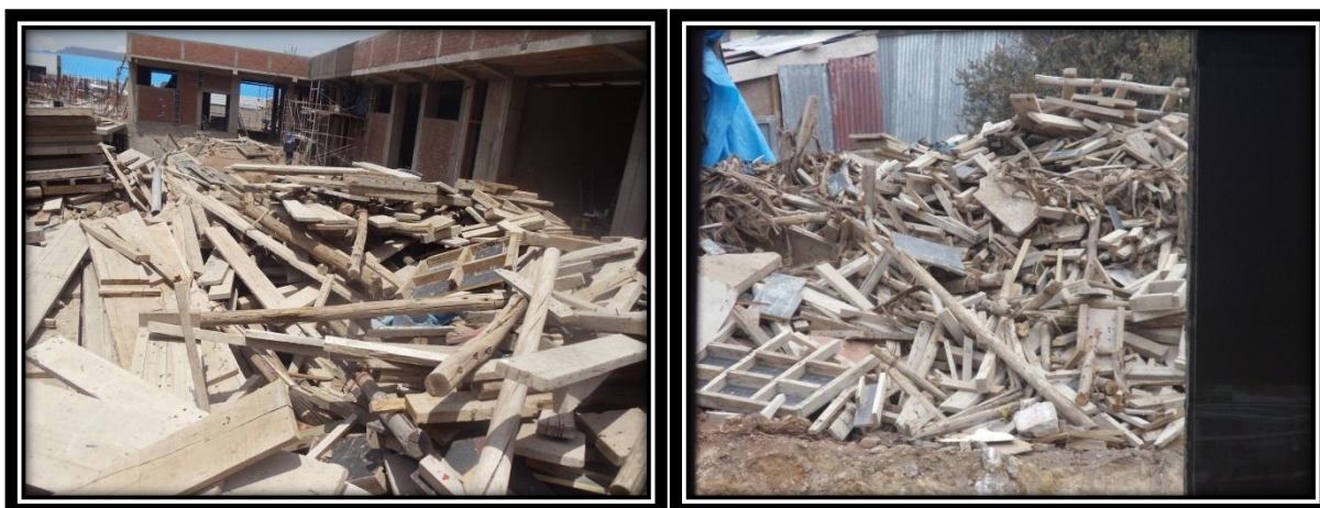
Izquierda: Retazos de madera en campo de obra frente de sectores “F” y “G” Mega Laboratorio Clínico
