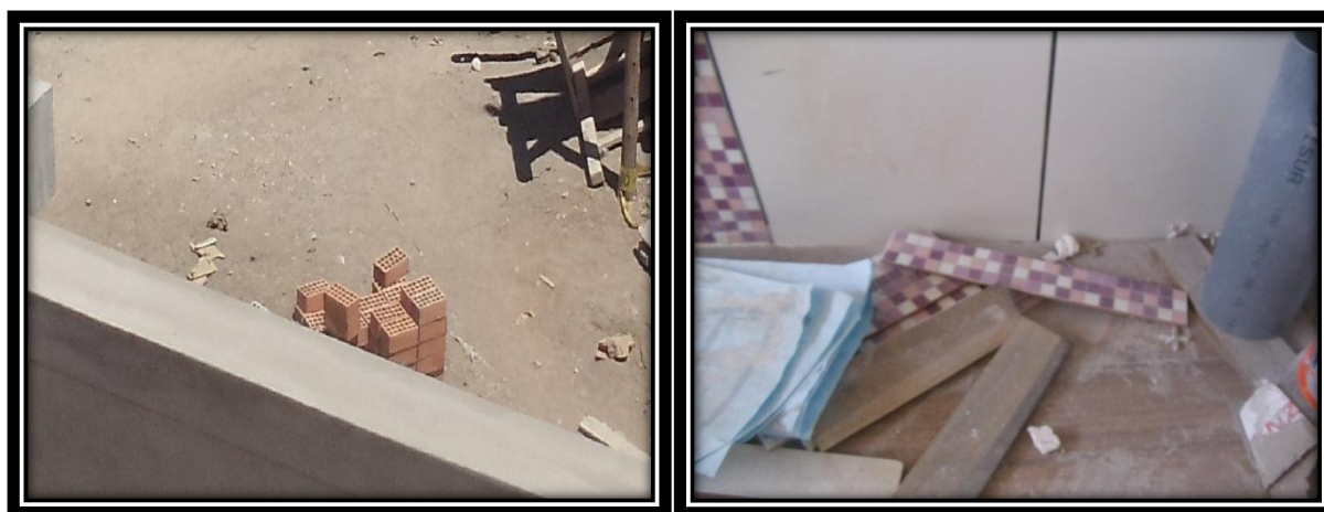
Izquierda: Ladrillos King Kong para albañilería en campo de obra frente a salón de grados Escuela Profesional de Trabajo Social
