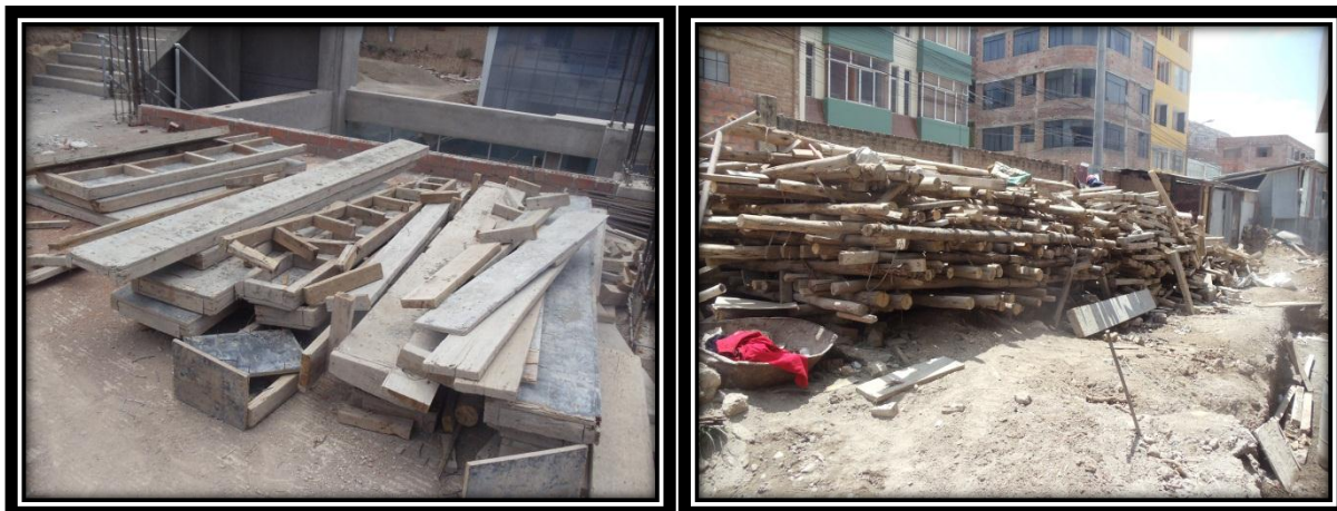
Izquierda: Encofrados no reutilizables en 2do nivel sector “E” Mega Laboratorio Clínico
