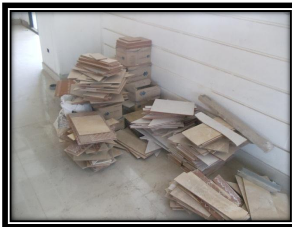
Izquierda: Cerámicos para pisos inservibles en interior 1er nivel sector “C” Mega Laboratorio Clínico
