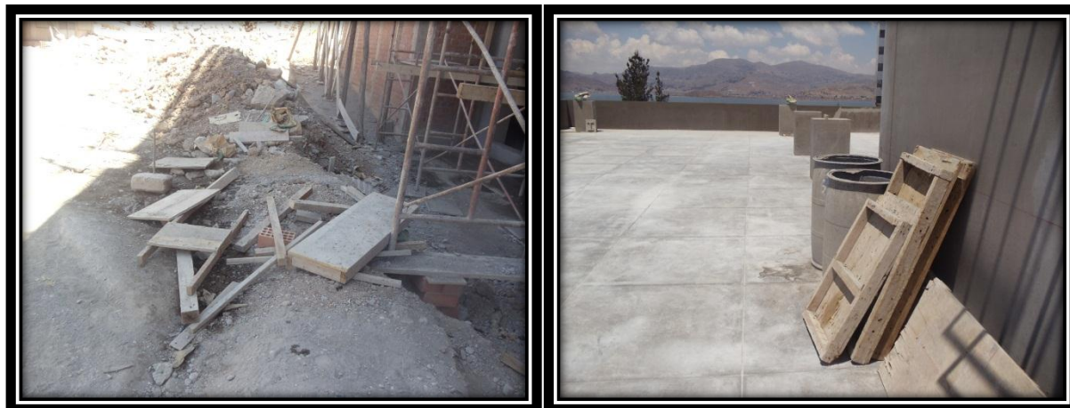
Izquierda: Encofrados no reutilizables en campo de obra frente a acceso principal Escuela Profesional de Trabajo Social
