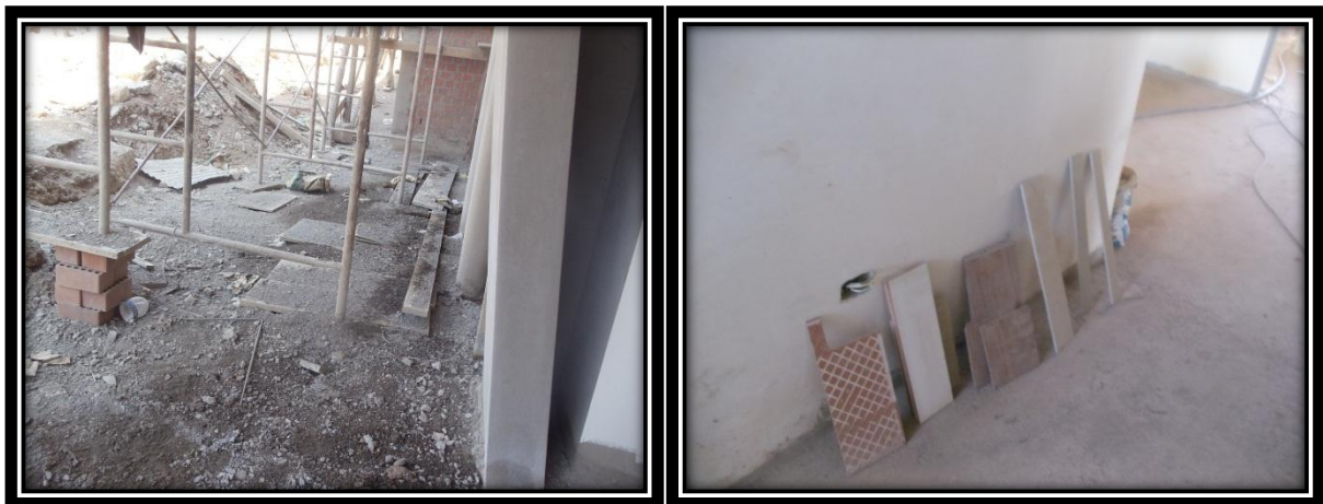
Izquierda: Ladrillos King Kong para albañilería en campo de obra frente a acceso principal en soporte de andamio Escuela Profesional de Trabajo Social
