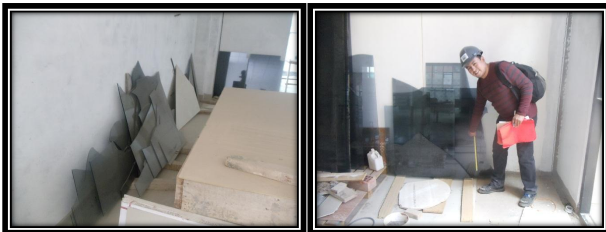
Izquierda: Vidrio laminado transparente inservible en interior 2do nivel sector "B" Mega Laboratorio Clínico
