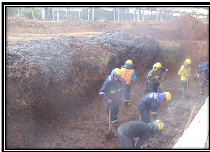
Figura N° 7: Residuos provenientes de excavaciones en Complejo Deportivo Universitario
