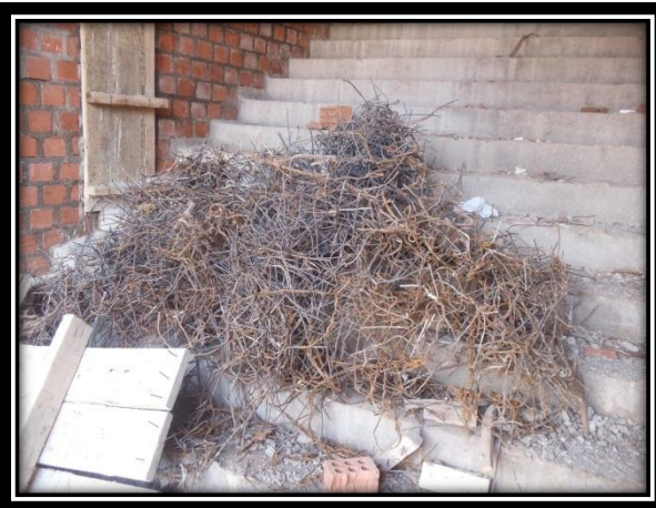
Izquierda: Alambres para encofrado inservibles en exterior 1er nivel Tribuna Oriente Complejo Deportivo Universitario
