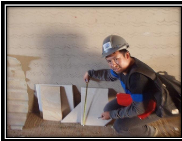
Izquierda: Medición de cerámicos inservibles en interior 1er nivel sector “D” Mega Laboratorio Clínico
