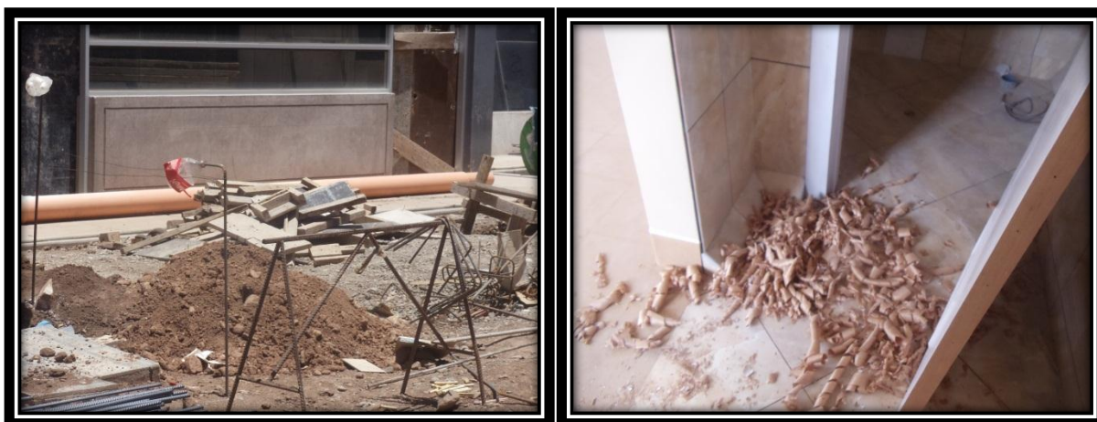
Izquierda: Material de escombros en campo de obra entre sectores “A” y “F” Mega Laboratorio Clínico
