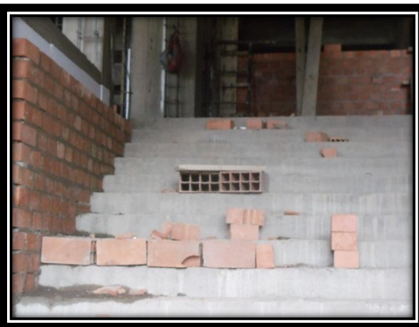
Izquierda: Ladrillos huecos para aligerado inservibles en interior 1er nivel Tribuna Occidente Complejo Deportivo Universitario
