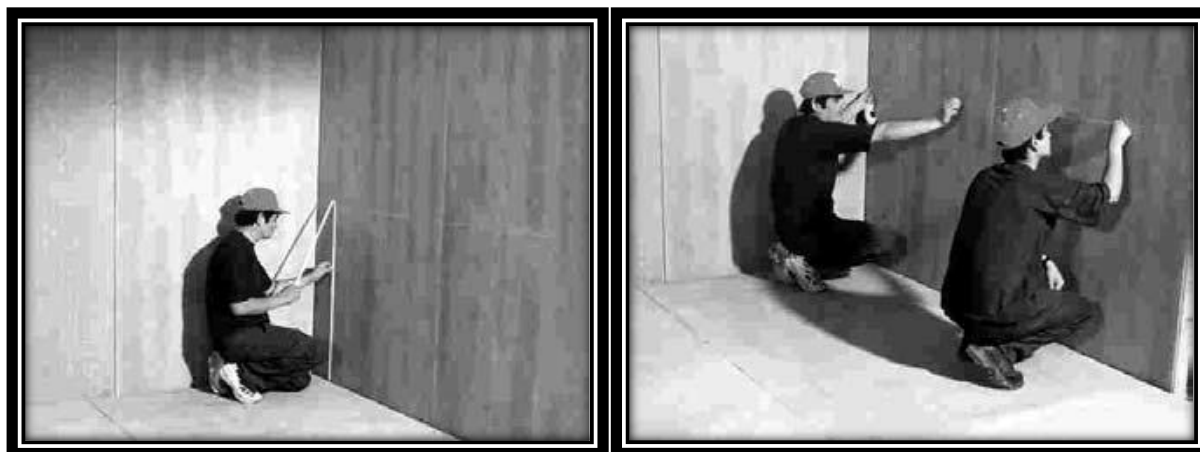
Figura N° 29: a) Izquierda: Marcado de medidas en el muro. b) Derecha: Determinación de desniveles perimetrales.
