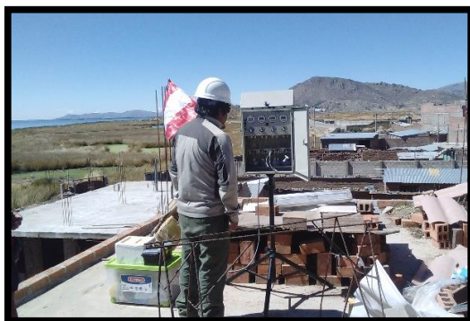
FOTO N° 1. Instalación del equipo Tren muestreo.
