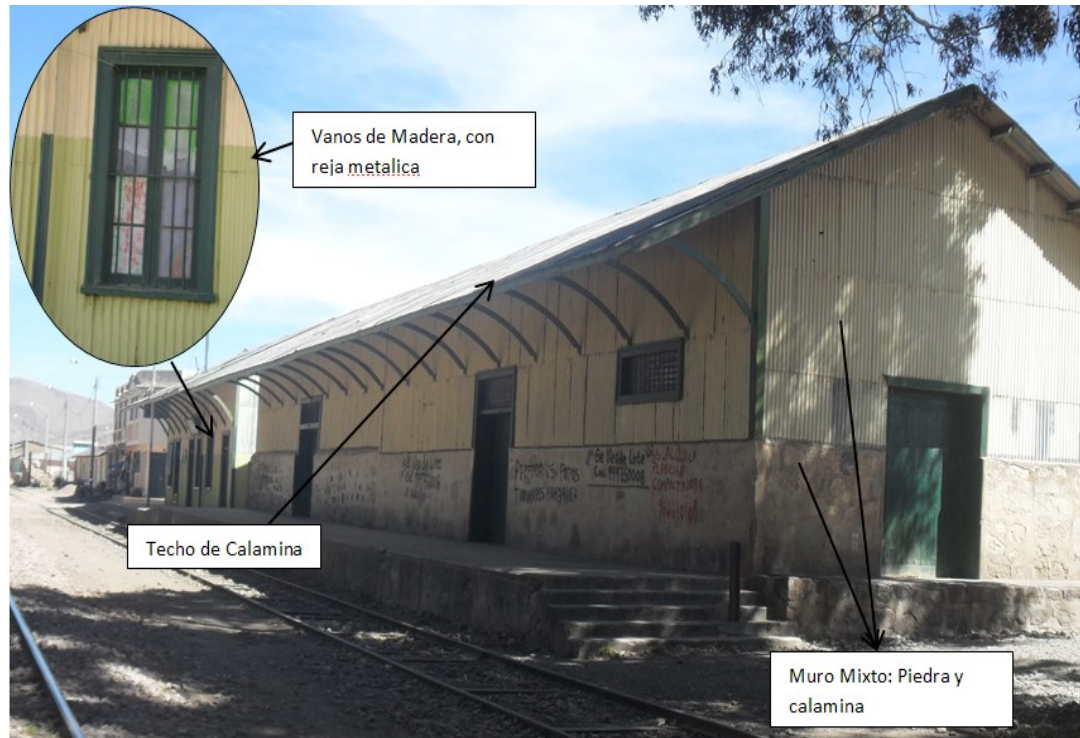
Figura 13: Antigua estación del tren (estudio de fachada)
