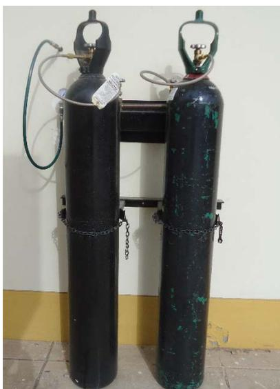
Figura N° 21: Aire comprimido medicinal de 50.2 Lt por botella
