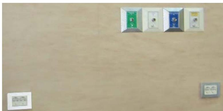
Figura N° 12: Tomacorriente en sala de operaciones.
