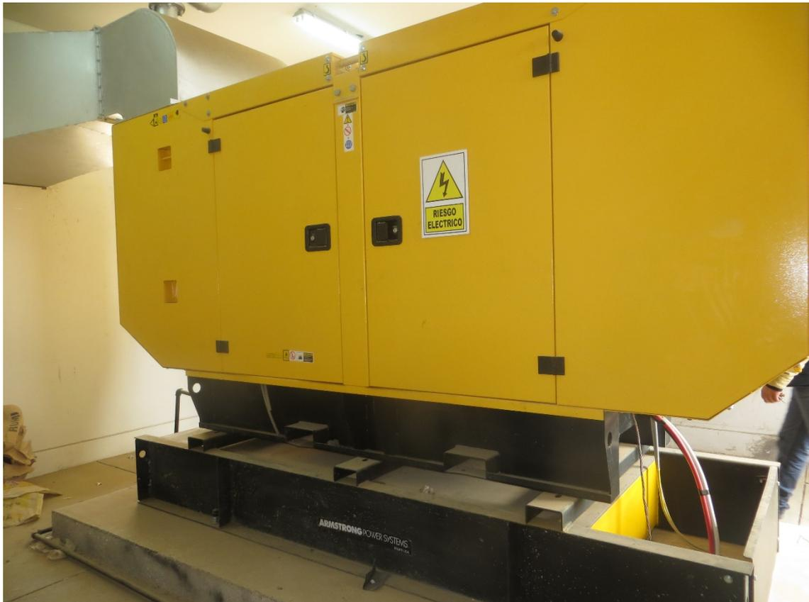
Figura N° 26: Grupo electrógeno de 165 KVA
