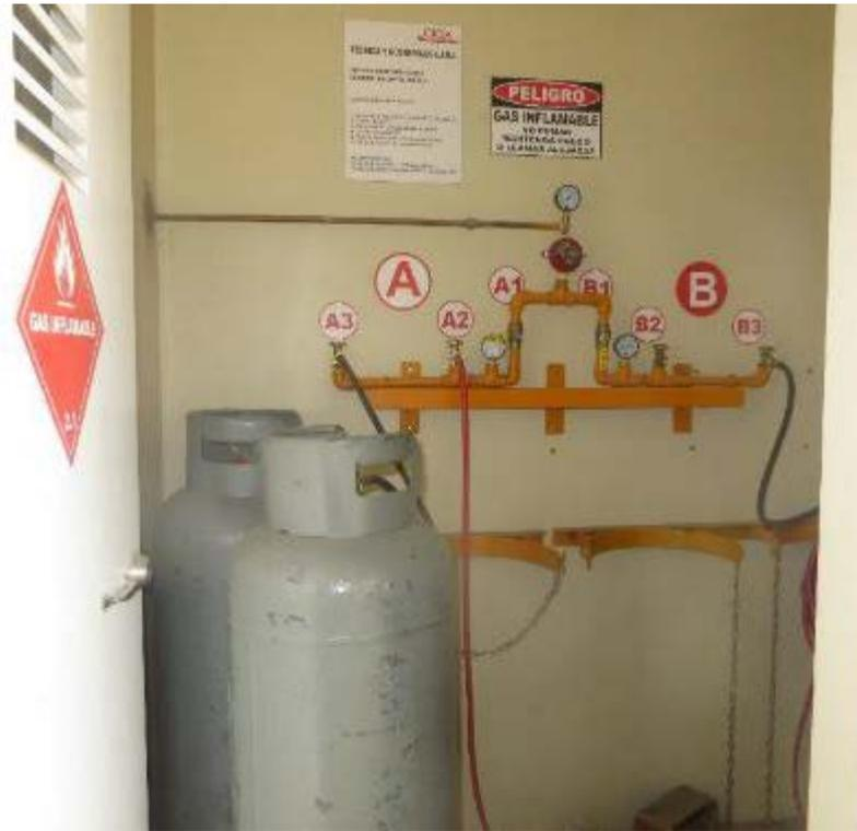
Figura N° 23: Central de GLP conformado por 45 Kg.
