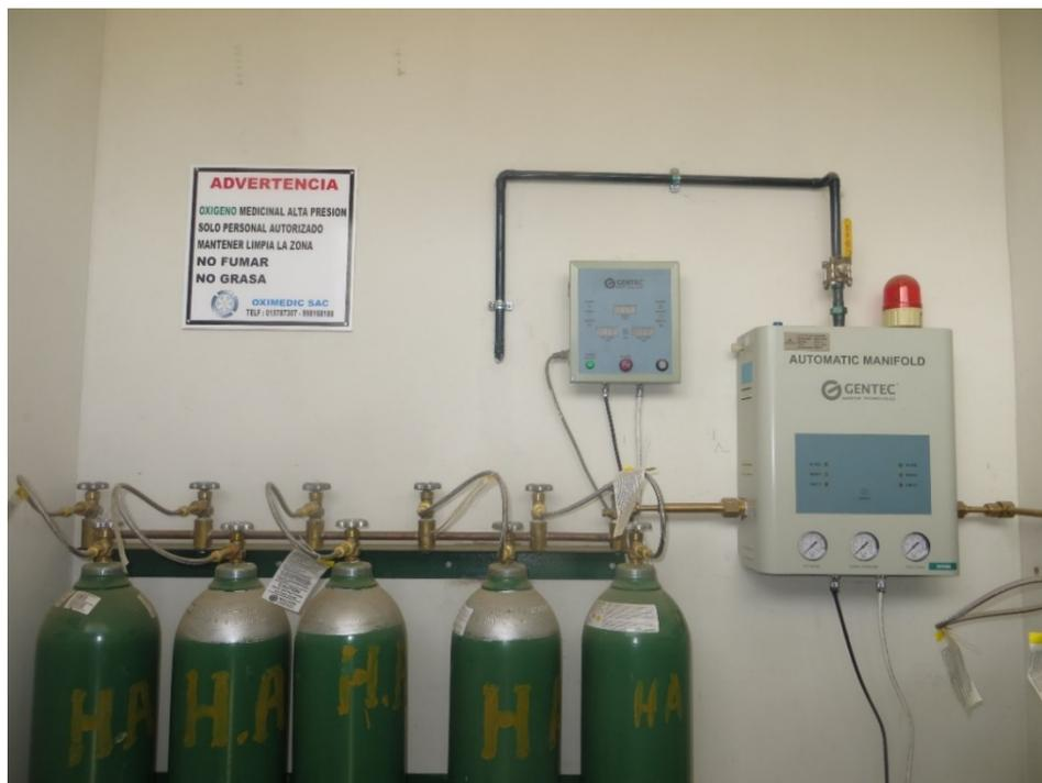
Figura N° 17: central de oxígeno de 10 cilindros de 40 lt divididos en dos bancadas
