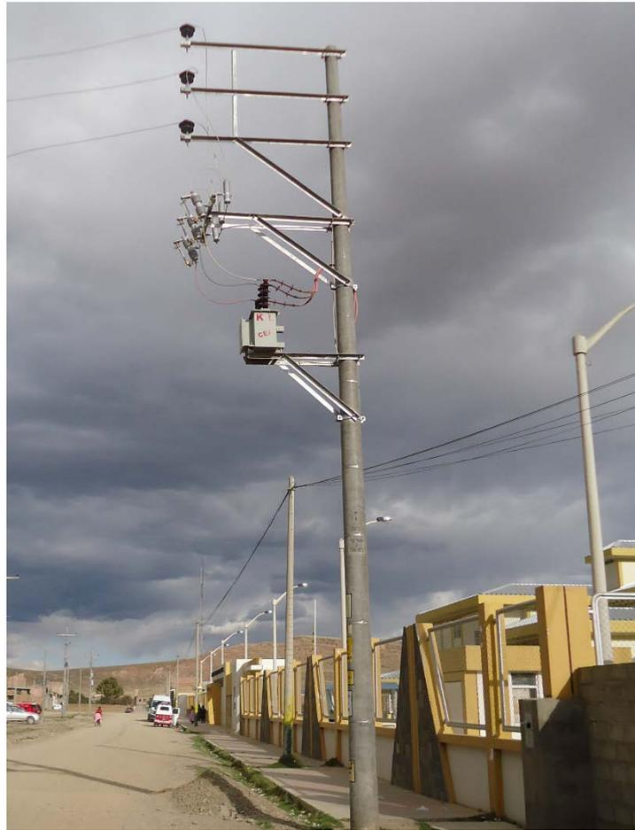
Figura N° 7: Suministro de energía eléctrica 10KV punto de medición a la intemperie.
