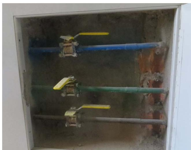
Figura N° 18: Válvula de piso de gases medicinales
