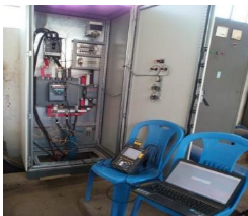
Foto 7,8: Tableros de control bomba de impulsión N°1 /impulsión N°2
