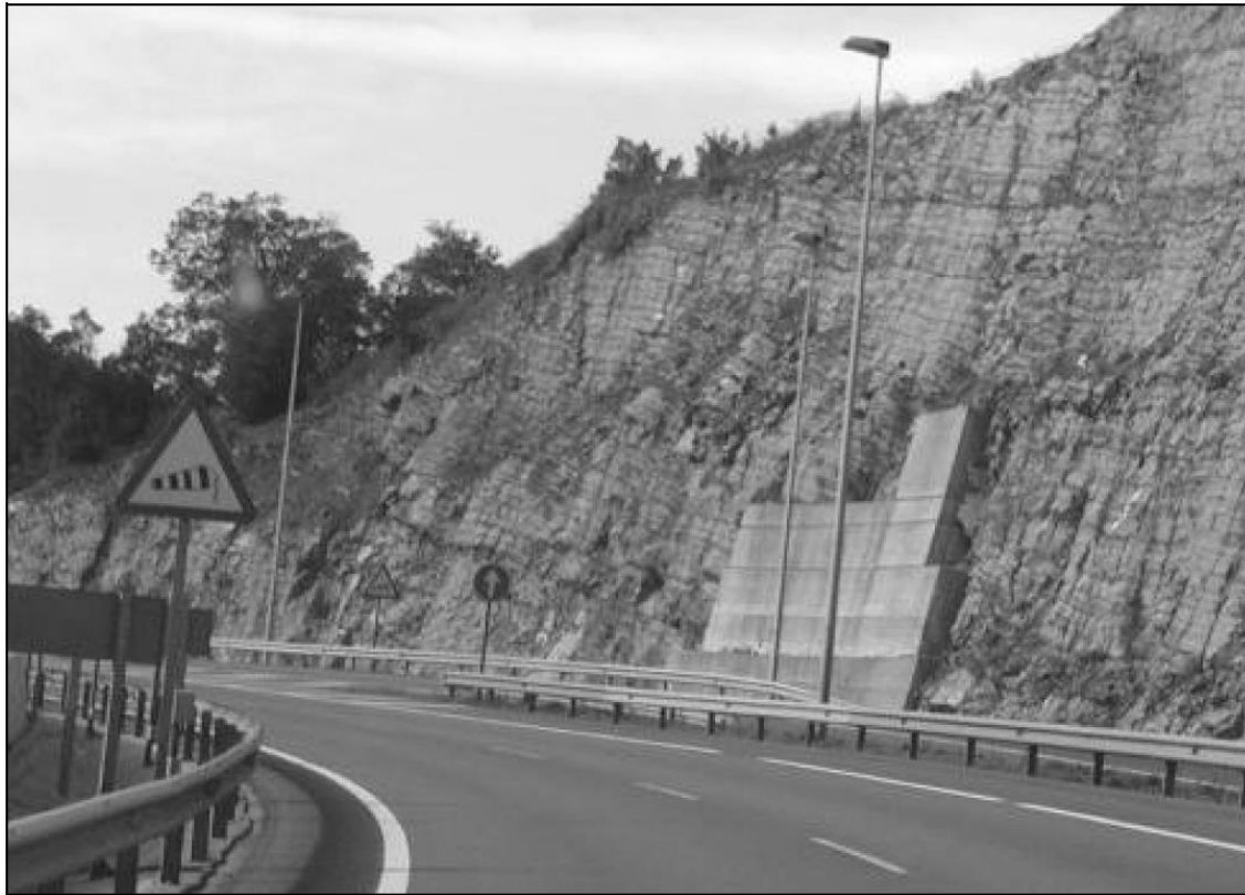
Figura 26: Muro de hormigón armado en macizo rocoso.
