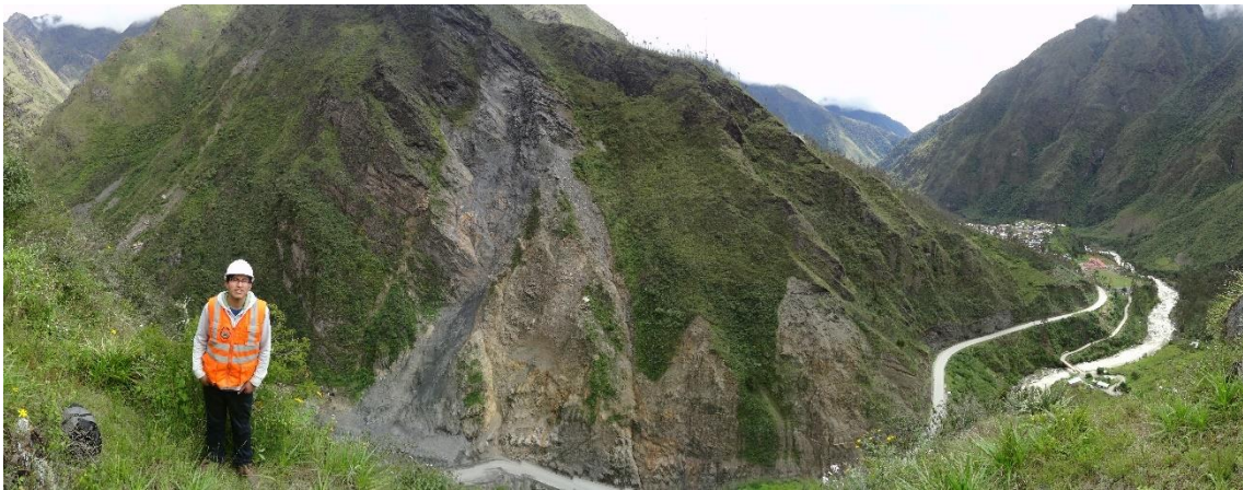
Figura C. 22. Vista panorámica del talud desde el frente
