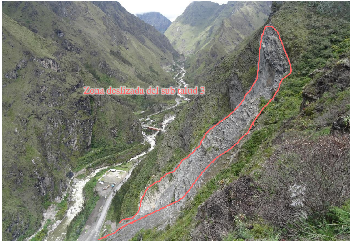
Figura C. 16. Sub talud 3, vista desde la parte superior del talud Qoñiunu
