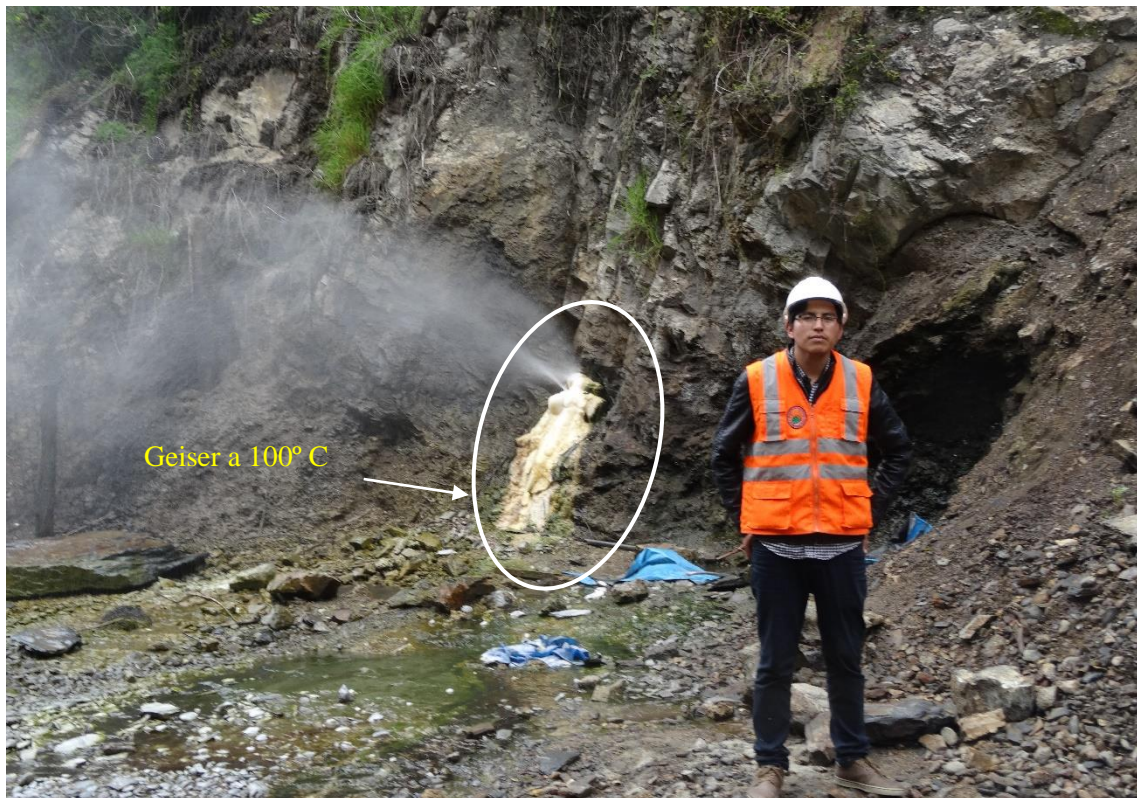
Figura C. 14. Geiser en el pie del sub talud 2
