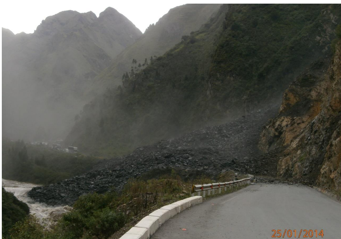
Figura 1: Derrumbe en el Km 232+240 ocurrido el 25 de enero del 2014
