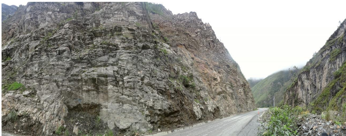
Figura C. 15. Sub talud 4, vista hacia el NE
