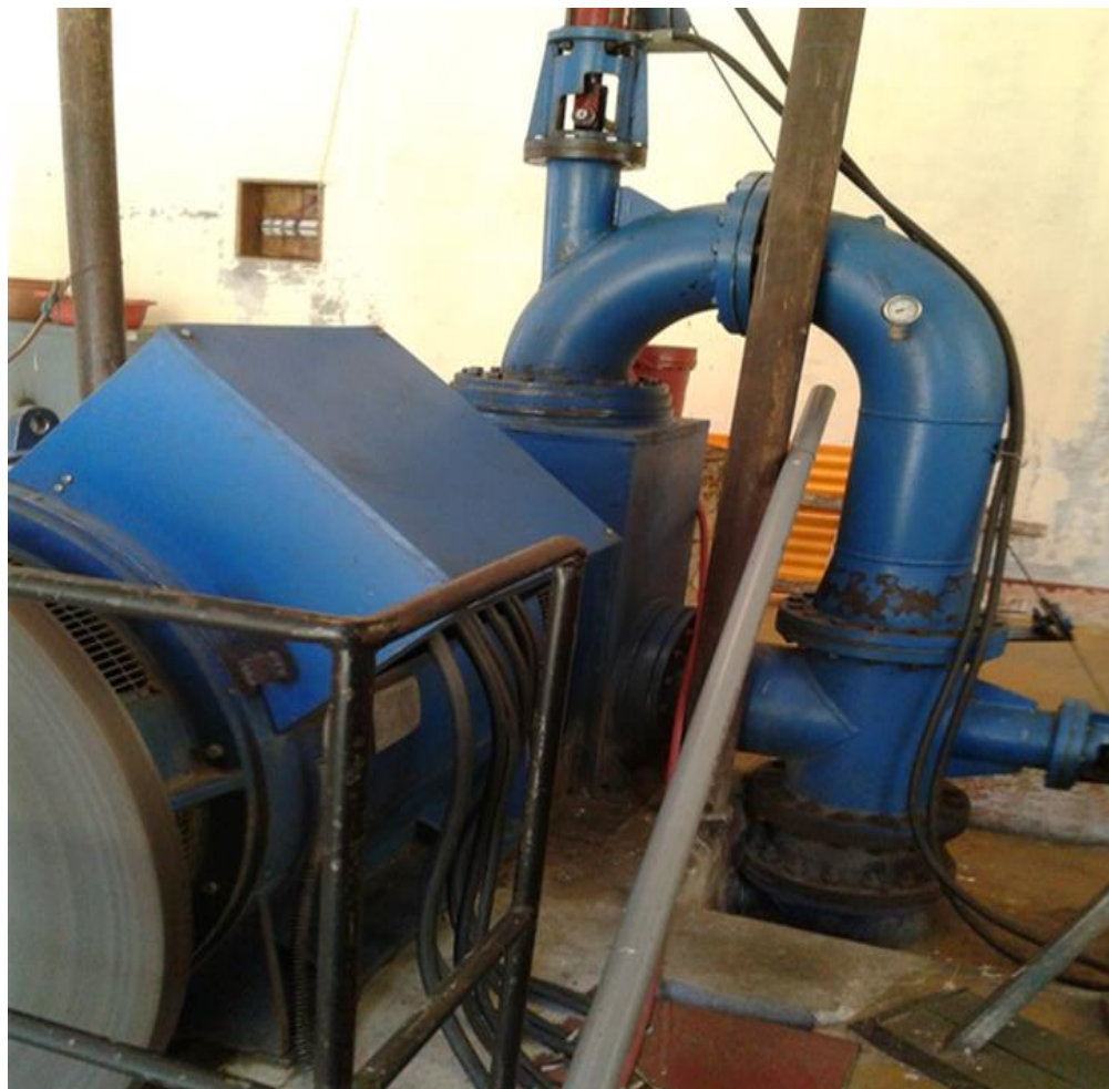
Figura 2: Vista del montaje de la micro-hidroeléctrica Lurini
