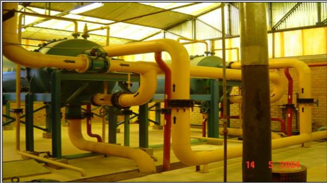
Figura 17. Zona de filtros clarificadores de la planta *Merrill Crowe*
