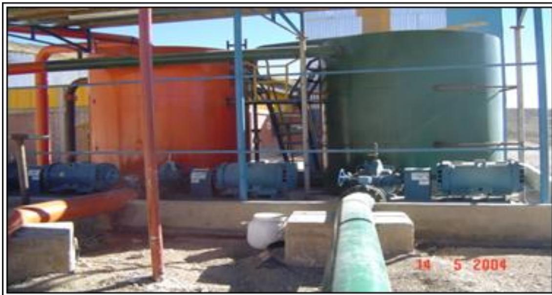
Figura 21 Tanques de solución tratada planta *Merrill-Crowe*
