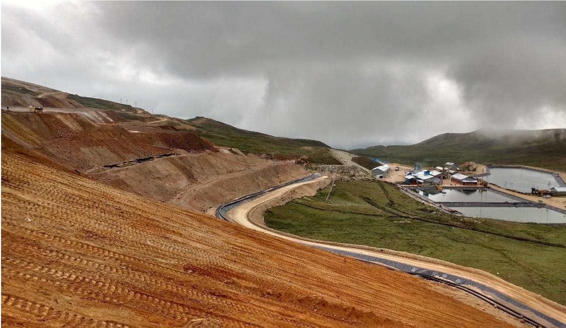
Figura 16. *Pad* de lixiviación y planta *Merrill-Crowe*.
