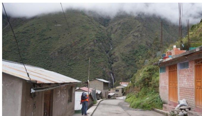
Foto N°8: Erosión por escurrimiento o erosión en cauces.
