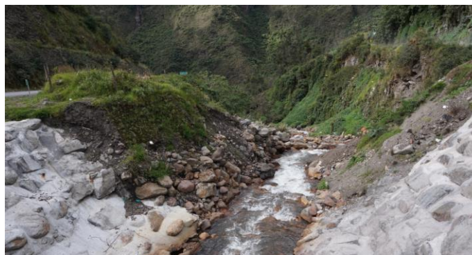
Foto N°7: Ensanchamiento por Erosión.
