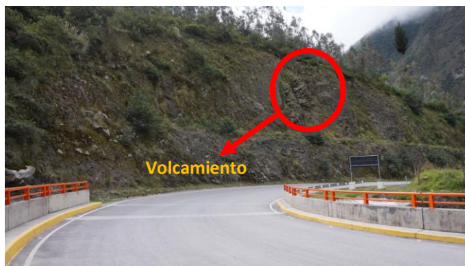
Foto N°2: Tipo de movimiento de masa, Volcamiento.
