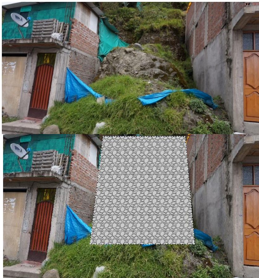
Figura 29: Muros de contención para que no permitan que estas masas de roca asuman sus pendientes naturales.
