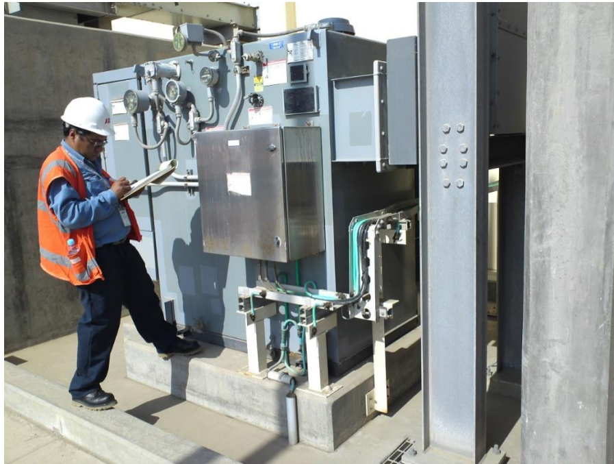
Figura 15: Toma de datos para filtrado de aceite dieléctrico
