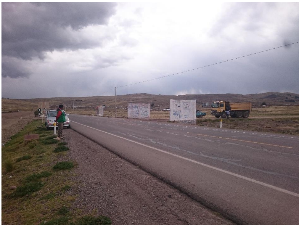
Figura 30. Falta de señalización vertical - información. TCA-06 Fuente: Elaboración propia
