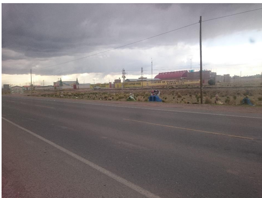
Figura 25. Demarcación horizontal desgastada, reduciendo la retroreflectividad de sus líneas TCA-01
