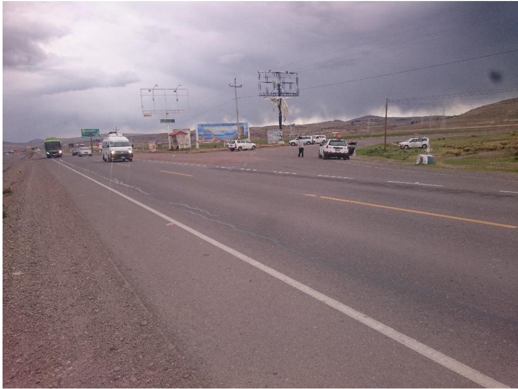
Figura 28. Falta de señalización vertical - información. TCA-05 Fuente: Elaboración propia
