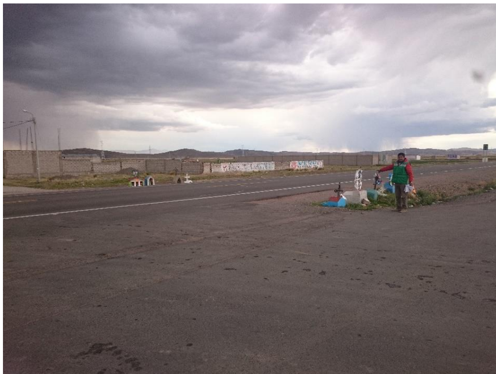
Figura 27. Ausencia de tachas y mantenimiento de demarcación horizontal. TCA-04 Fuente: Elaboración propia
