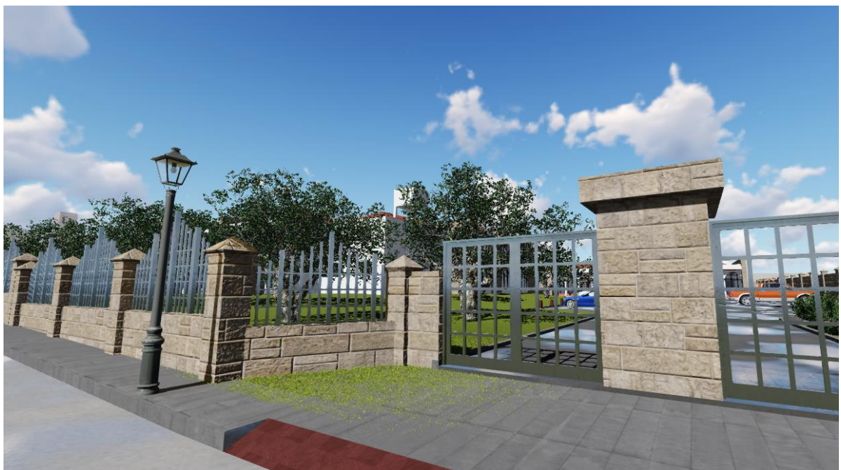
Figura 79 Vista Ingreso Vehicular Escuela Taller Lampa
