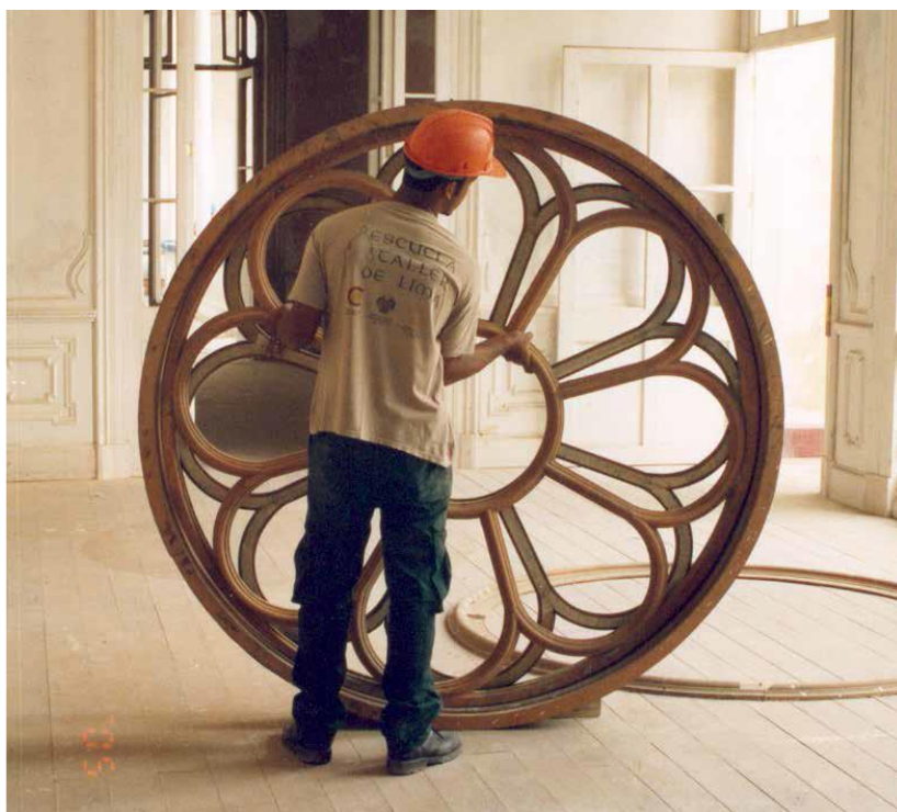
Figura 18 Restauración Integral de la Casa Aspíllaga
