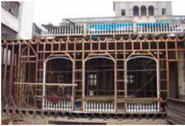
Figura 19 Restauración integral de la Casa Aspíllaga
