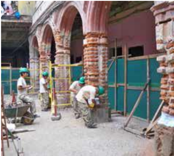
Figura 20 Casa de la Columna. Consolidación de columnas
